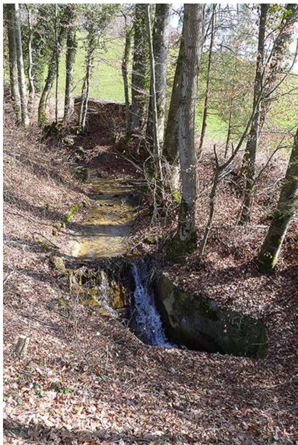
Bild 3.19 Zollbach vor Strasse nach Krummbach mit hinterfüllter Schwelle und anschliessendem Durchlass (22.3.2013).
