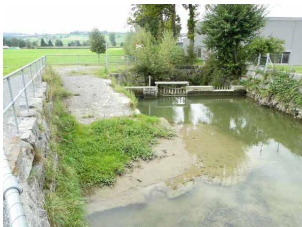
Bild 3.32 Geschiebesammler vor SBB-Durchlass mit Zufahrt und Betonsperre. Blick in Fliessrichtung (21.9.2010).
