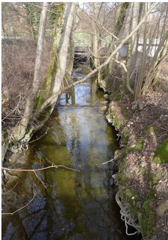
Bild 2.20 (oben rechts) Meierhofbach eingangs Sempach mit Aufweitung und Rechen. Fliessrichtung von rechts nach links (7.1.2013).
