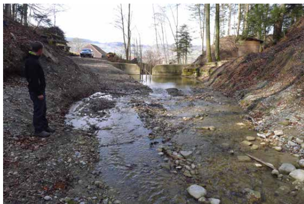
Bild 3.50 Geschiebe- und Schwemmholzsammler am Tobelausgang des Gründelbachs. Blick in Fliessrichtung von der Stauwurzel mit Geschiebeablagerungen zur Sperre (22.3.2013).
