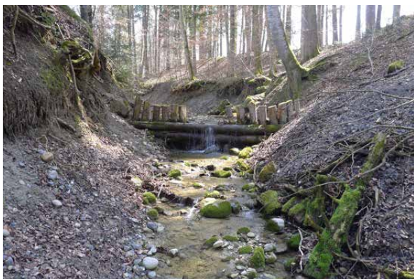
Bild 3.9 Alte Holzsperrre zur Sohlensicherung im oberen Abschnitt der Tobelstrecke (Blick flussaufwärts) (17.4.2013).
