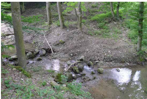
Bild 3.4 Huetterbach, Blockschwellen mit ausgeräumten Zwischenstrecken und seitlich deponiertem Kies. Fliessrichtung von links nach rechts (26.6.2013).
