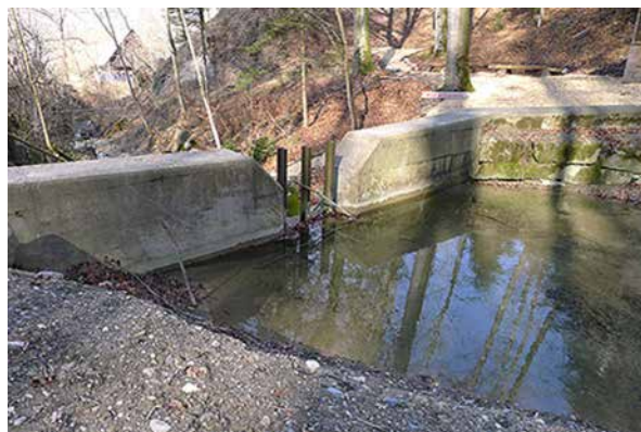
Bild 3.51 Betonsperre Gründelbach mit Überfallsektion und Grobrechen. 22.3.2013.
