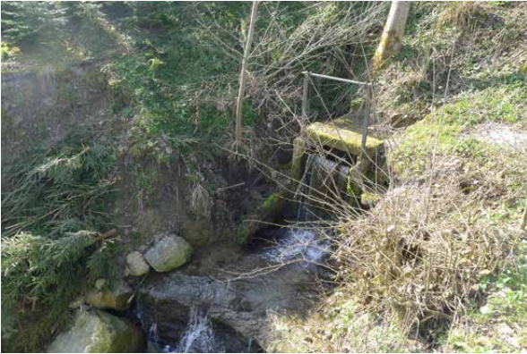
Bild 2.5 (oben) Lippenrütibach Anlage 1, Stauwehr nach Durchlass. 17.4.2013.
