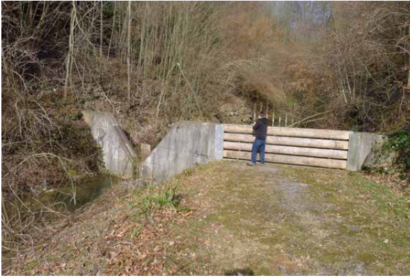
Bild 2.26 Rückhaltesperre mit vorgelagertem Rechen (im Hintergrund zu sehen). Blick gegen Fließrichtung. 22.3.2013.
