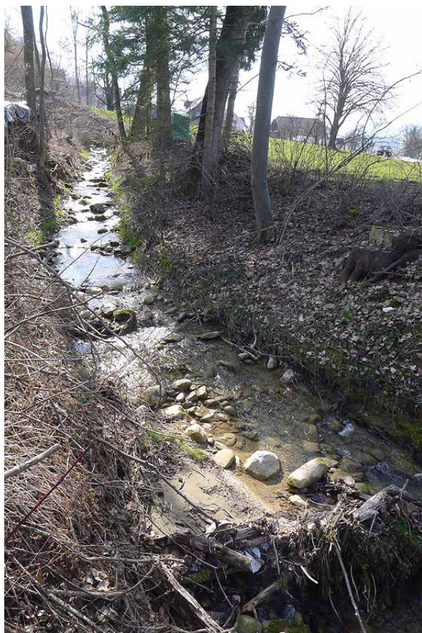
Bild 3.47 Gründelbach, Abschnitt 2. Abgepflästerte Sohle ohne Geschiebeablagerungen. Blick flussaufwärts. 22.3.2013.
