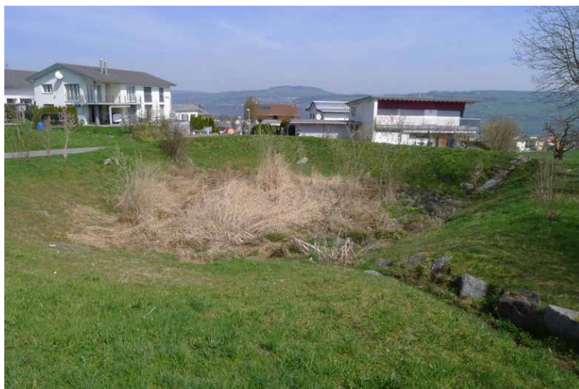
Bild 2.15 Hochwasserrückhaltebecken Eibach. Vorne rechts Einlauf, hinten rechts Auslauf mit Rechen und Überfallsektion. 17.4.2013.
