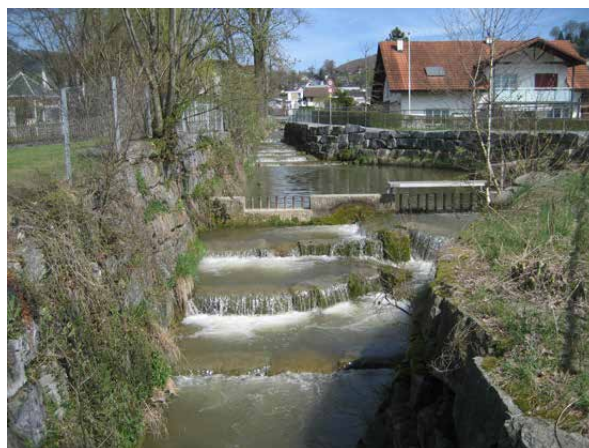
Bild 3.33 Geschiebesammler vor SBB-Durchlass mit nachfolgenden Schwellen. Blick flussaufwärts zum Sammler (6.4.2011).
