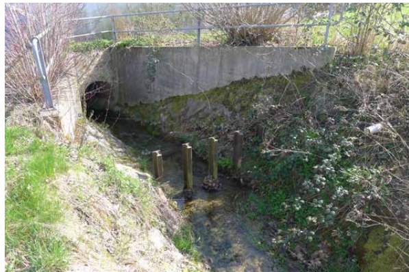
Bild 2.8 (oben) Sandplattenbach, oberes Ende Schwemmholtz- und Geschiebesammler. Blick flussaufwärts. 17.4.2013.
