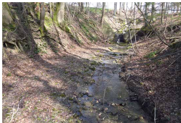
Bild 3.10 Betonsperre (Hintergrund) und Zwischenstrecke bis zur nächsten Sperre mit flacher und kolmatierter Geschiebebank (Blick flussaufwärts) (17.4.2013).
