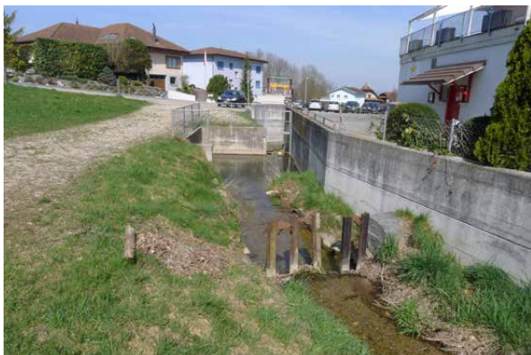
Bild 2.13 Anlage 1. Feststoffsammler mit vorgelagertem Rechen und Betonbecken. Blick flussabwärts. 17.4.2013.
