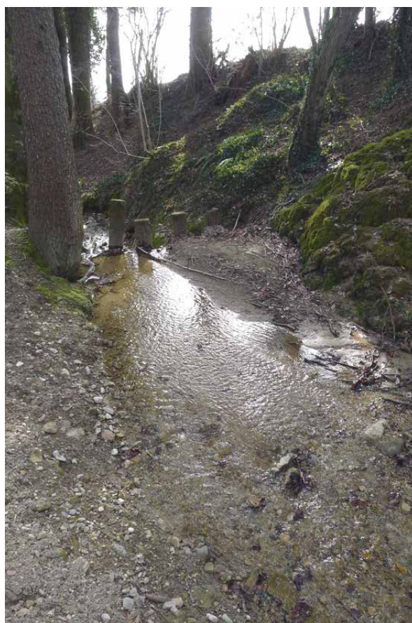
Bild 2.18 Schwemmholz- und Geschiebesammler mit Sohlenanhebung. Blick flussabwärts (22.3.2013).
