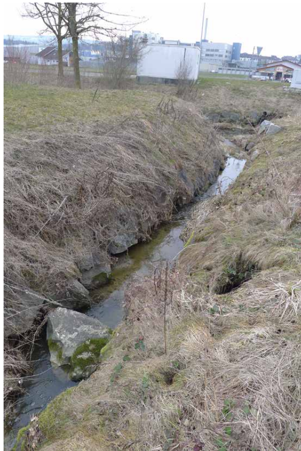
Bild 2-8 Birgenbach: Ausgebauter Abschnitt mit Ufersicherungen, Hochstauden und lokalen Kiesablagerungen (wahrscheinlich Umlagerungen aus Sohle). Fliessrichtung von rechts nach links (6.3.2013).
