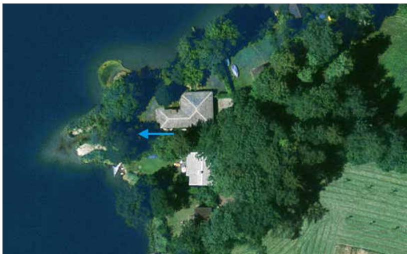
Bild 5-24 Luftbild Delta mit bachnahen Gebäuden.
