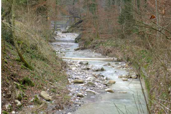
Bild 5-11 Breites Gerinne mit Schwellen und gut strukturierten Bänken. Blick flussaufwärts zur Sperre des Geschiebesammlers (7.1.2013).
