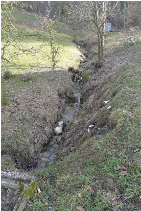
Bild 4-25 (oben) Unterspülter Uferschutz im Bereich der Steilstrecke (6.3.2013).
