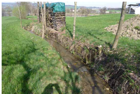
Bild 3-3 Mündungsstrecke: Einengung und Ufersicherung mit Metallgittern (17.4.2013).
