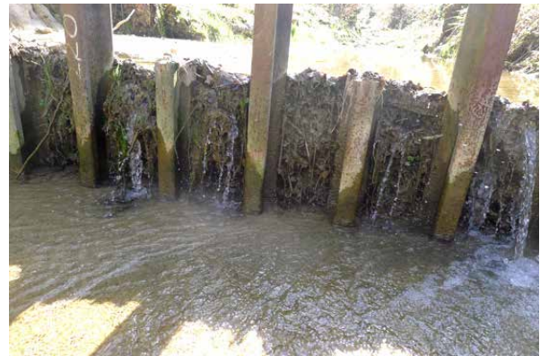
Bild 3-14 Rechen, Blick gegen Flussrichtung (17.4.2013).
