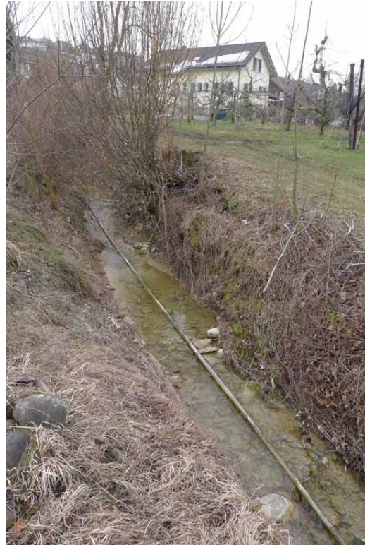
Bild 4-4 (rechts) Ausgeräumte Flachstrecke unterhalb der Kantonsstrasse, Blick flussaufwärts (6.3.2013).
