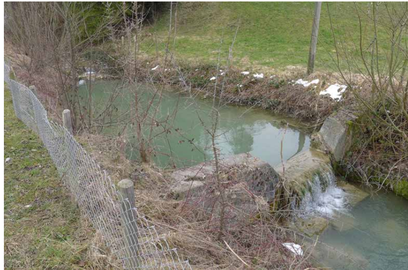
Bild 4-6 Geschieberückhaltebecken mit Endschwelle. 6.3.2013.
