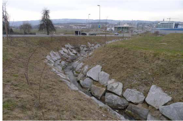
Bild 2-12 Eingeengtes Gerinne mit hart verbauten Ufern im Unterlauf des Sammlers. Blick flussabwärts. 6.3.2013.
