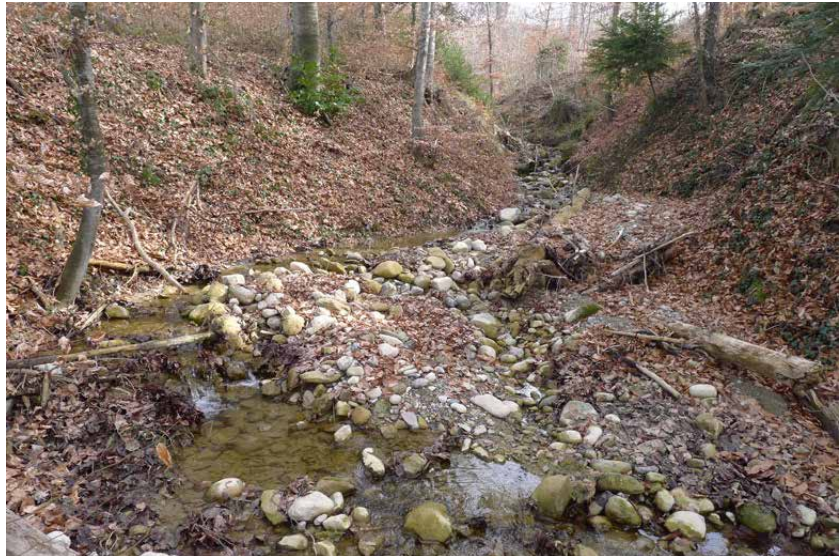
Bild 4-8 Tobelstrecke Grenzbach mit eher steilen Talflanken, grober Sohle und Bänken. 6.3.2013.
