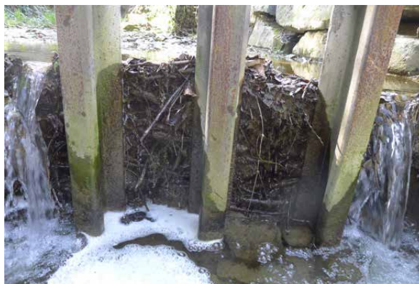
Bild 2-17 Verkläuserung des Rechens mit feinen Ästen und Laub (17.4.2013).
