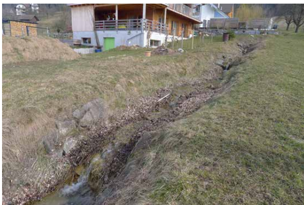
Bild 4-18 Steiler und verbauter Abschnitt oberhalb der Kantonsstrasse (Blick flussaufwärts).
