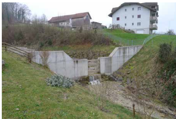
Bild 5-26 Geschiebesammler Hinterbach: Schlitzsperre mit Holzbalken vom Unterwasser betrachtet.
