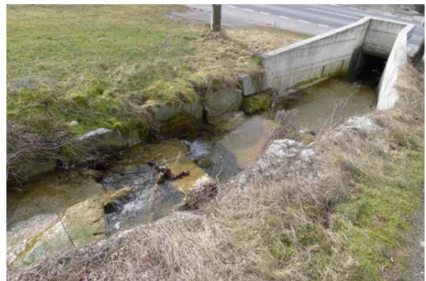
Bild 4-10 Mit Blöcken gesicherte Sohle vor dem Durchlass Kantonsstrasse (6.3.2013).
