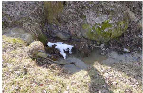
Bild 4-25 (oben) Unterspülter Uferschutz im Bereich der Steilstrecke (6.3.2013).
