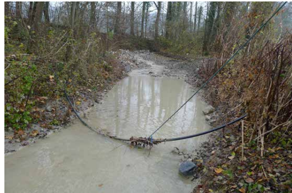
Bild 5-8 Kiesentnahmestelle Geren, Blick von der Endschwelle flussaufwärts (22.11.2012).
