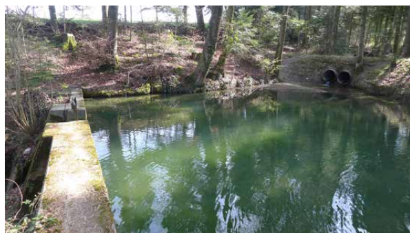
Bild 3-5 Sperre mit Becken und Zulauf oben rechts (17.4.2013).
