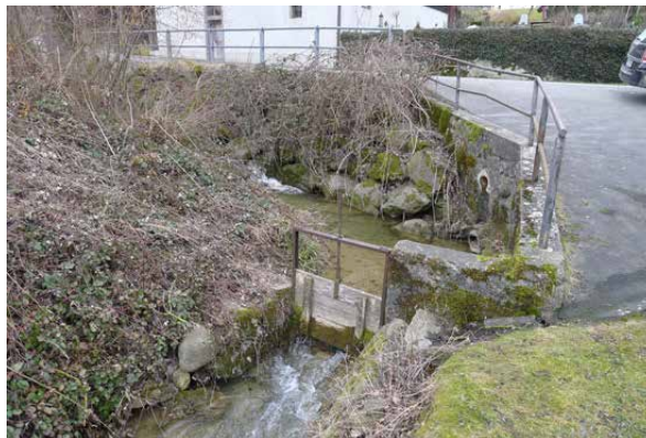
Bild 3-19 Schieber zur Regulierung der Wassermengen. 6.3.2013
