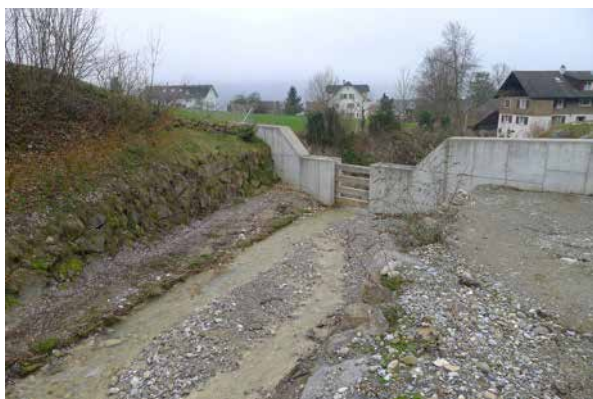
Bild 5-25 Geschiebesammler Hinterbach mit gegliedertem Rückhalteraum (7.1.2013).
