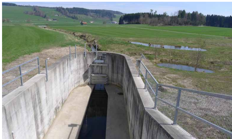
Bild 6-1 Durchlassbauwerk beim Hochwasserrückhaltebecken
