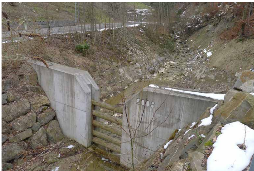
Bild 3-34 Geschiebesperre mit leerem Becken. 6.3.2012.
