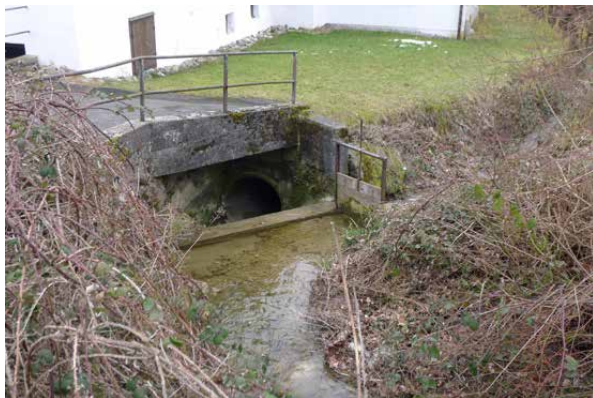
Bild 3-18 Wehrschwelle mit anschliessender Eindolung sowie Fassung mit Schieber. 6.3.2013
