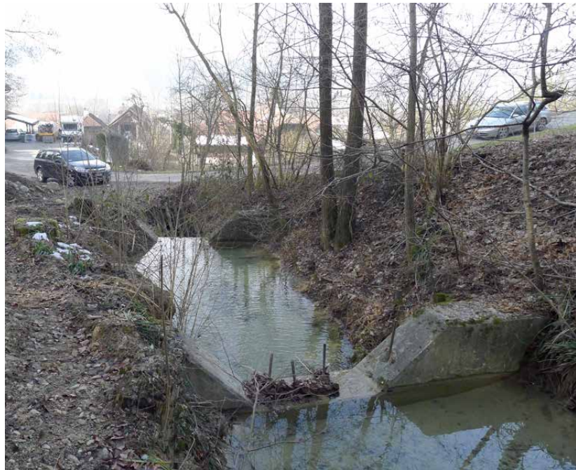
Bild 4-27 Geschiebesperre mit leerem Becken (Blick in Fließrichtung). 6.3.2013.
