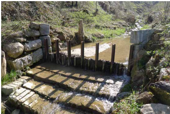
Bild 3-13 Rechen und abgelagertes Feinmaterial, Blick in Flussrichtung (17.4.2013).
