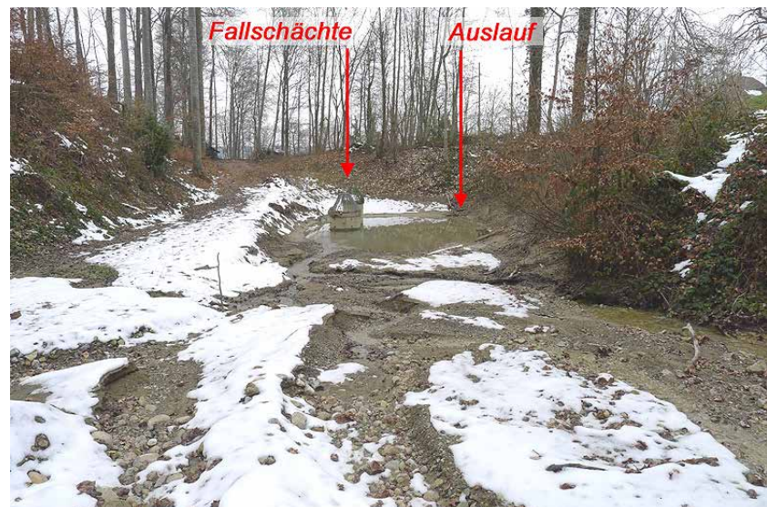
Bild 4-5 Geschiebesperre mit Rückhaltevolumen und beiden Fallschächten. 6.3.2013.
