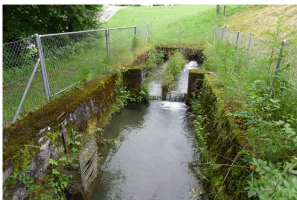
Bild 6-3 Betonbecken mit 2 Einlaufkammern und anschliessendem Becken mit Auslass und Feinrechen. (26.6.2013).
