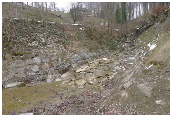
Bild 3-36 Blockrampe im Zulaufbereich des Rückhalterausms. 6.3.2013.
