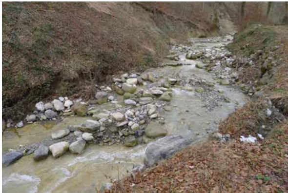
Bild 5-2 Abschnitt 1: Natürliche Tobelstrecke mit Bänken auf Felssohle. 8.3.2013.
