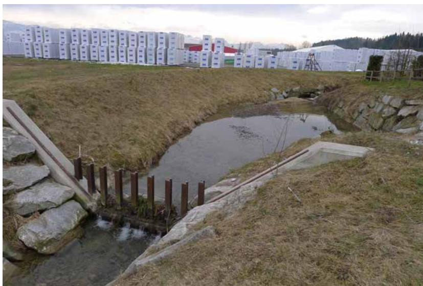
Bild 2-10 Endschwelle mit Rechen und leerem Becken. 6.3.2013.
