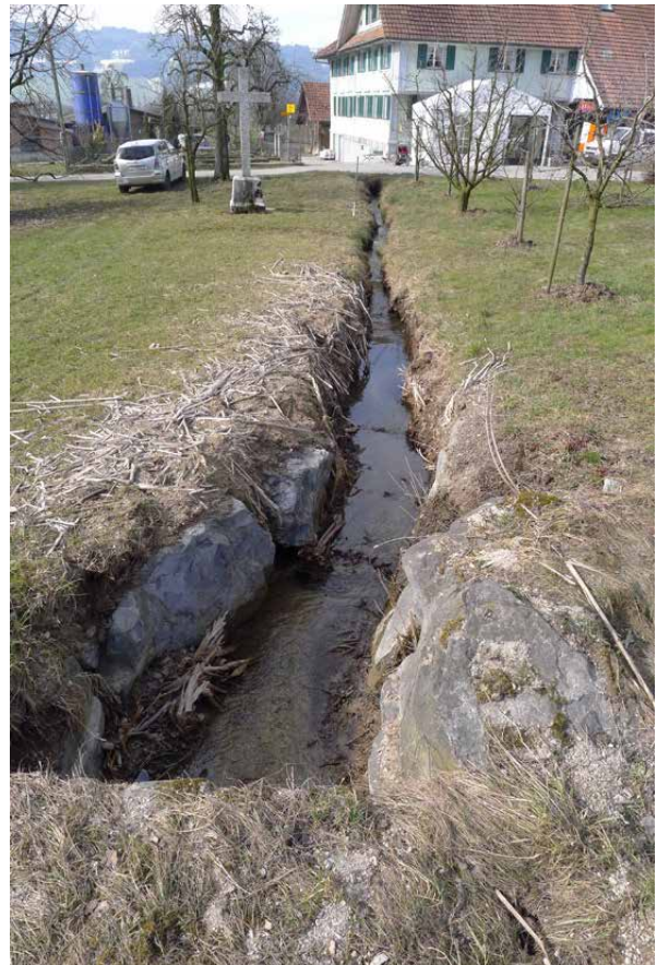
Bild 4-19 Stark eingengter Abschnitt im Bereich der Alten Landstrasse (Blick flussabwärts).
