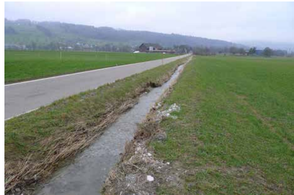
Bild 5-3 Abschnitt 3: Kanalisierte Flachstrecke vor Mosen. Blick flussabwärts. 26.1.2012
