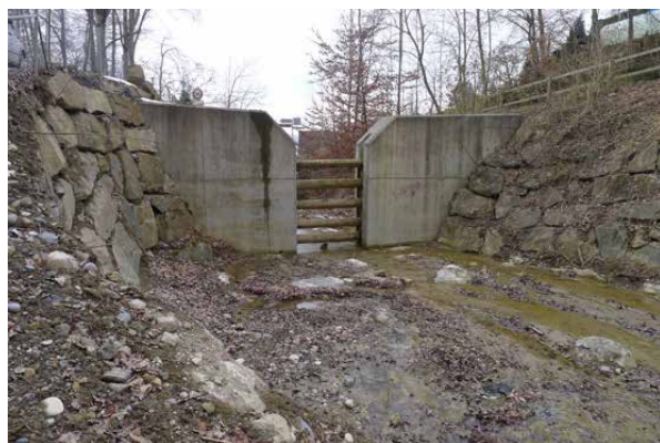
Bild 3-35 Geschiebesperre mit Rückhalteraum. 6.3.2013.
