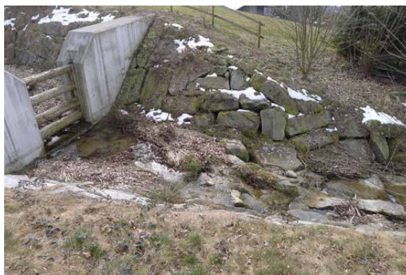
Bild 4-14 Schlitzsperre und Unterwasserbereich. 6.3.2013.
