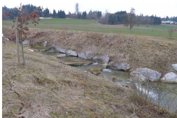
Bild 2-1 Regelmässige Schwellen vor dem Aufenthaltsbereich (6.3.2013).
