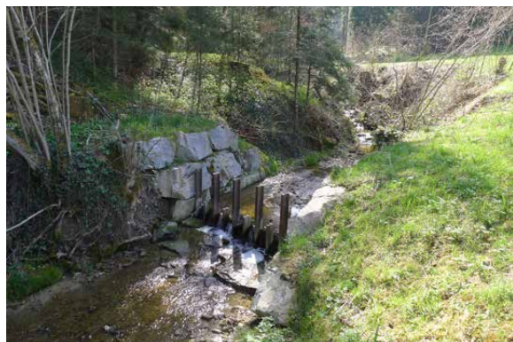
Bild 2-16 Rechen am Sagenbach. Ufer und Sohle mit Blöcken gesichert, Blick gegen Fliessrichtung (17.4.2013).
