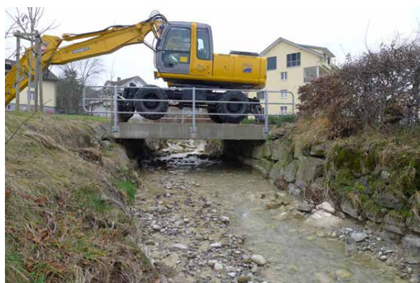
Bild 5-21 Geschiebeablagerungen entlang Kirchgasse.
