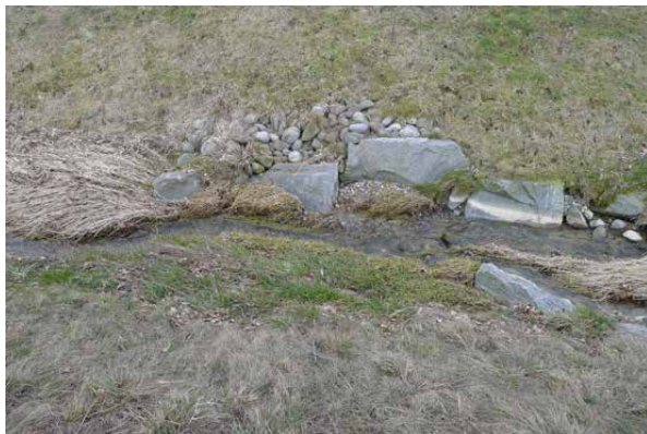
Bild 2-8 Birgenbach: Ausgebauter Abschnitt mit Ufersicherungen, Hochstauden und lokalen Kiesablagerungen (wahrscheinlich Umlagerungen aus Sohle). Fliessrichtung von rechts nach links (6.3.2013).
