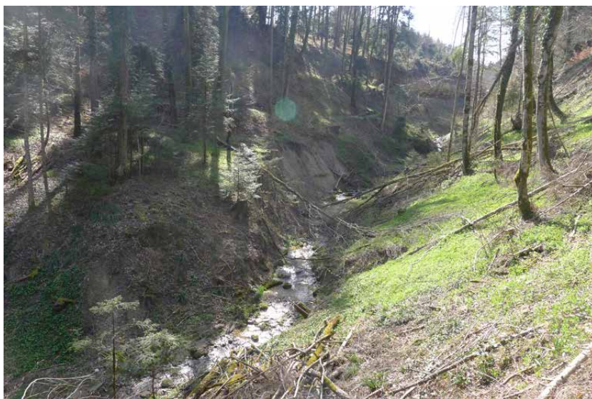
Bild 2-14 Natürliche Tobelstrecke mit Hanganriss und geringen Geschiebeablagerungen (17.4.2013).
