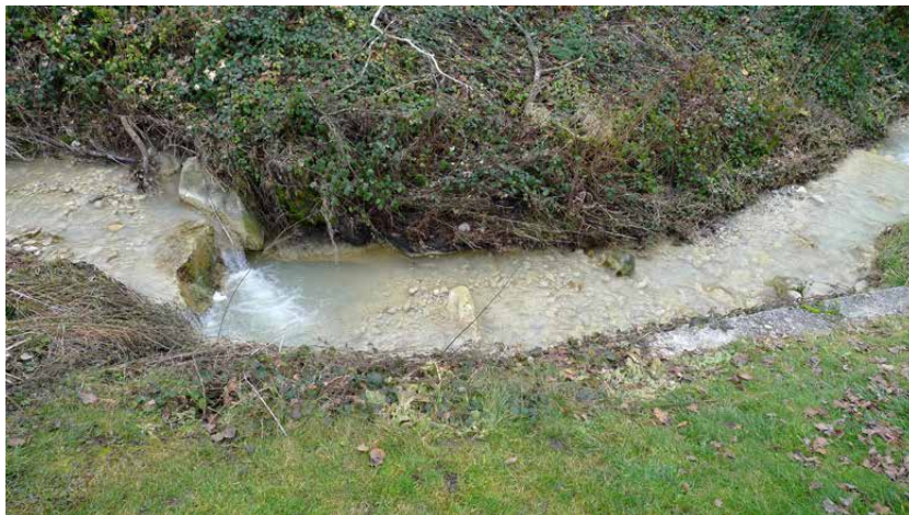
Bild 5-20 Hinterbach flussabwärts Geschiebesammler mit lockerer steiniger Sohle und kleinen Kiesbänken.
