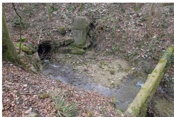
Bild 2-6 Kleine Geschiebebank zwischen der Rundholzschwelle (Bild 3.7) und dem Durchlass (6.3.2013).
