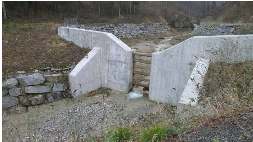
Bild 5-4 Geschiebesperre mit leerem Becken und Geschiebebank im Unterwasser. 26.1.2012.
