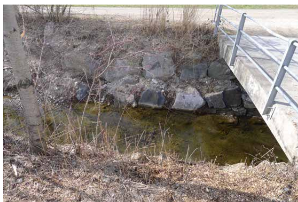
Bild 3-31 Ausgebaggerte Sohle flussabwärts SBB-Durchlass und Strassenbrücken (6.3.2013).
