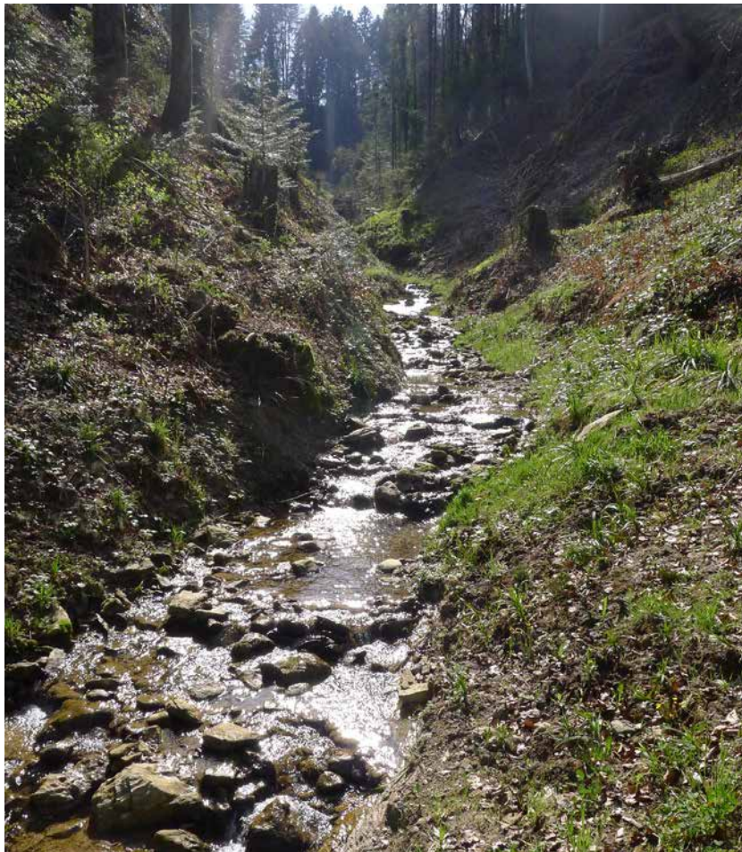
Bild 3-2 Tobelstrecke mit grober stabiler Sohle und vereinzelt Geschiebeablagerungen.
