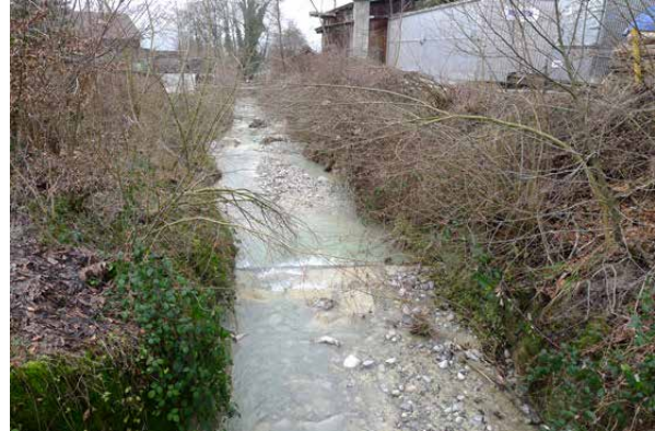
Bild 5-12 Eingeengter Vorderbach entlang Donaustrasse mit Schwellen und lockeren Geschiebeablagerungen (7.1.2013).
