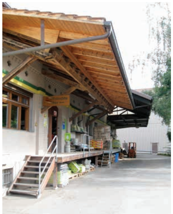
Ein Güterumschlagplatz muss überdacht, befestigt und abflusslos sein. Zusätzlich muss jederzeit Bindemittel bereit stehen.
