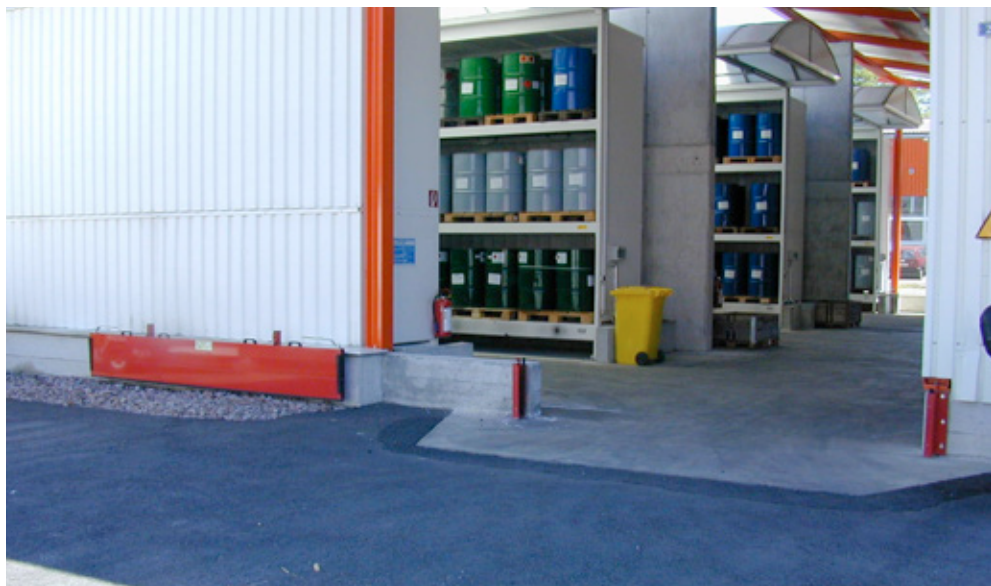
Manuelle Löschwasserbarriere
