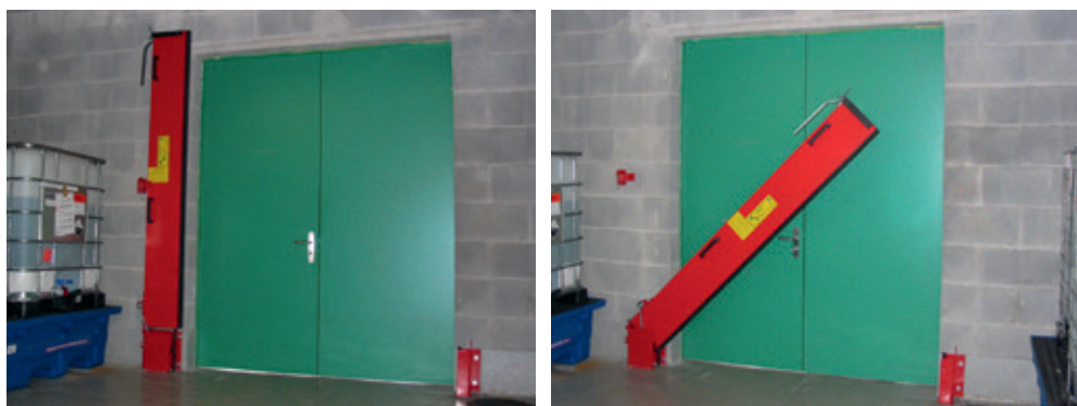
Halbautomatische Löschwasserbarriere
