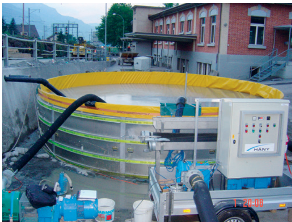
Beispiel eines mobilen Auffangbehälters
