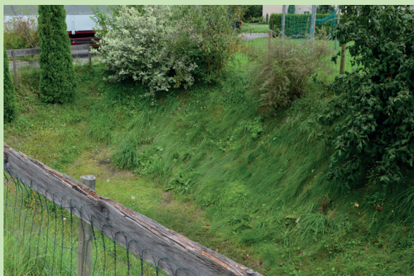
Eine Versickerungsanlage des Typs H.
