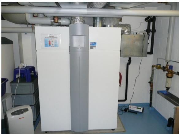
Integralsystem mit Lüftungsgerät und Wärmepumpe (Mitte). Revisionskasten des Luft-Erdwärmetauschers und Kondensatablauf (oben rechts). Der Siphon befindet sich hinter dem Integralsystem
