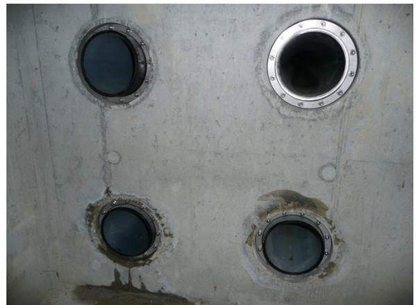
Mauerdurchführungen der L-EWT mit Kondenswasser (unten links)
