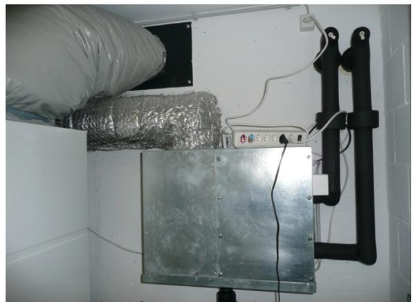
Revisionskasten des Luft-Erdwärmetauschers mit Kondensatablauf auf der Unterseite
