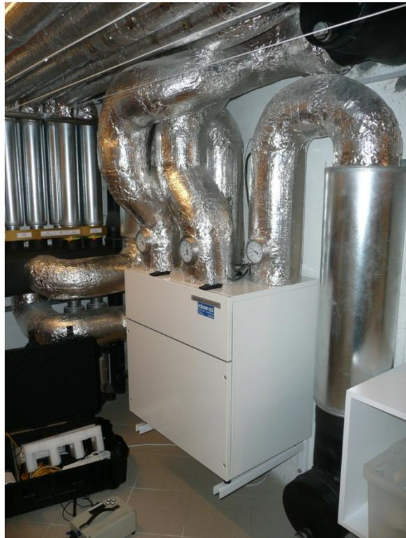
Technikraum mit Lüftungsanlage (Mitte), Mauerdurchführung des Luft-Erdwärmetauschers (unten rechts) und Luftverteilung (oben links)
