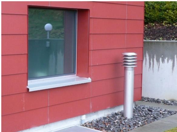
Abb. 19. Aussenluftfassung des EFH Buttisholz. Der Ansaugpunkt liegt bei ca. 0.9 m über offenem Kiesbett.
