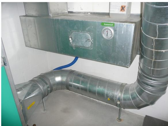
Revisionskasten des Luft-Erdwärmetauschers und Kondensatablauf (blaues Rohr)
