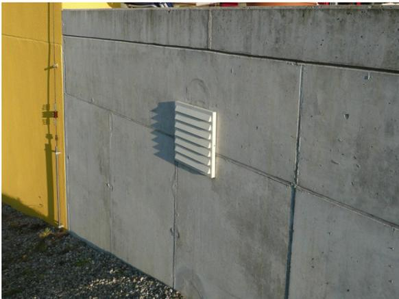
Abb. 17. Aussenluftfassung des EFH Malters 1. Der Ansaugpunkt liegt bei ca. 1 m über dem Terrain.
