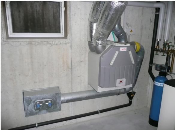
Lüftungsanlage mit Mauerdurchführung (unten
