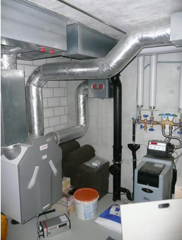
Technikraum mit Lüftungsanlage (links) und Revisionskasten des Luft-Erdwärmetauschers (Mitte oben)
