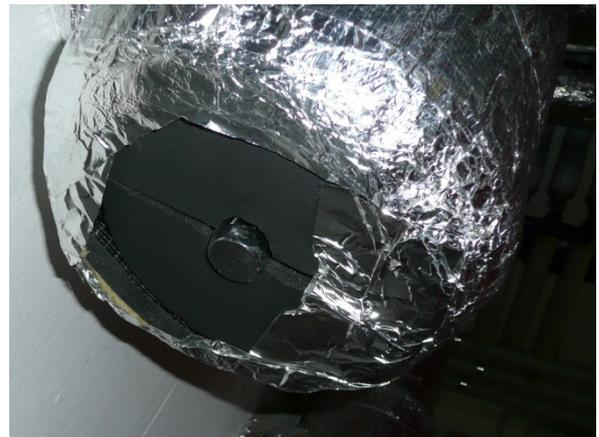
Detailansicht Kondensatablauf-Öffnung auf der Unterseite des Luft-Erdwärmetauschers
