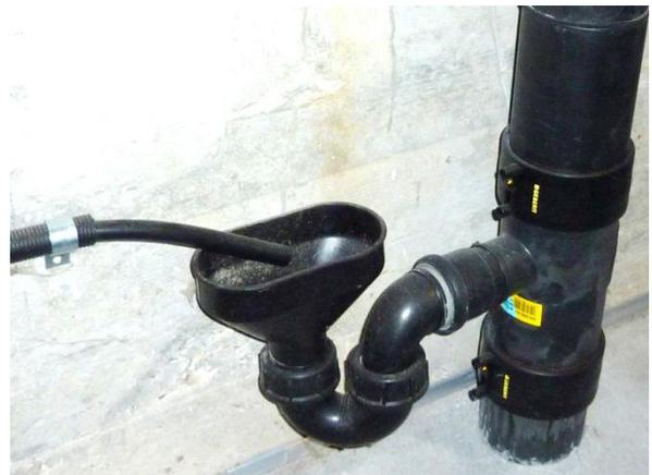
Rohrende des Kondensatablaufs (dünnes Rohr links). Der Siphon bietet in diesem Fall keinen Schutz gegen Radon
