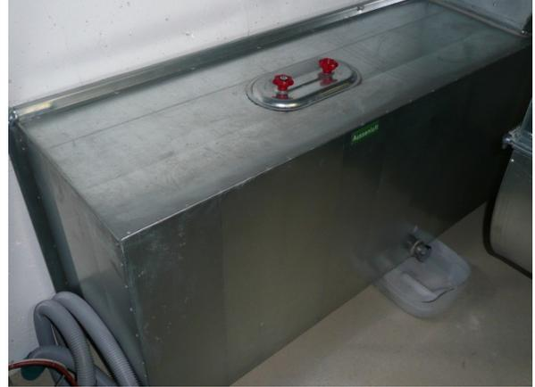
Revisionskasten des Luft-Erdwärmetauschers und Kondensatablauf-Öffnung (rechts)
