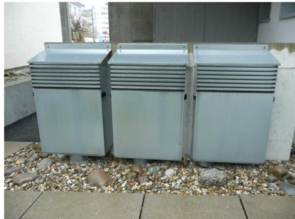
Abb. 20. Aussenluftfassungen mit Filterkasten beim MFH Willisau. Der Ansaugpunkt liegt bei ca. 0.8 m über offenem Kiesbett.
