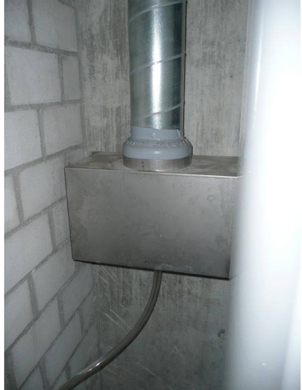
Mauerdurchführung des L-EWT mit Kondensatablauf (dünnes Rohr)
