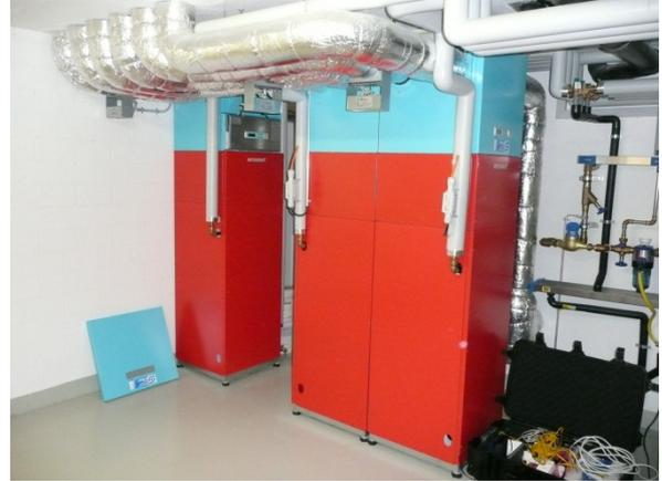
Technikraum mit den 3 Lüftungsanlagen
