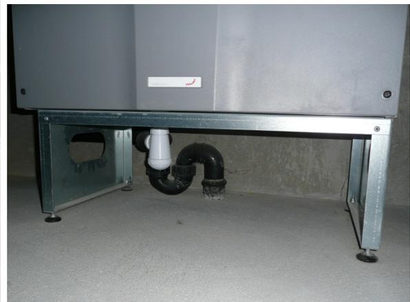
Detailansicht des Siphons unter dem Lüftungsgerät
