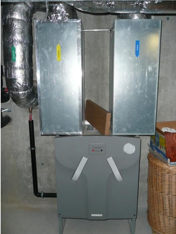
Lüftungsanlage mit Mauerdurchführung des Luft-Erdwärmetauschers und Kondensatablauf (links)
