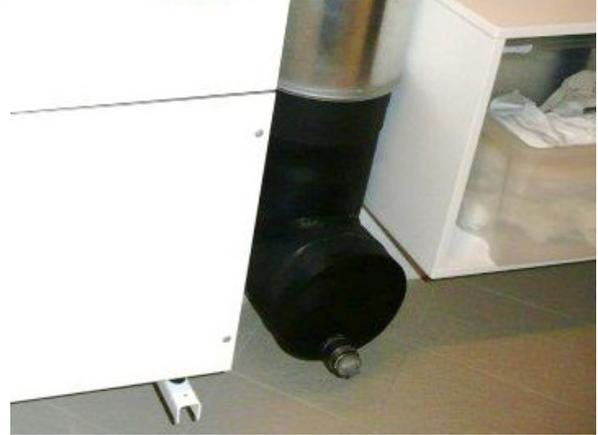
Mauerdurchführung des L-EWT und Kondensatablauf
