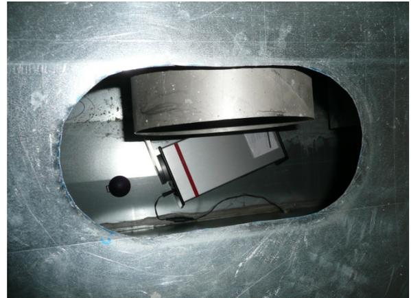
Messung der Radonkonzentration in der Luft aus dem L-EWT im Revisionskasten mittels Alpha-GUARD Radonmonitor und Passivdosimeter
