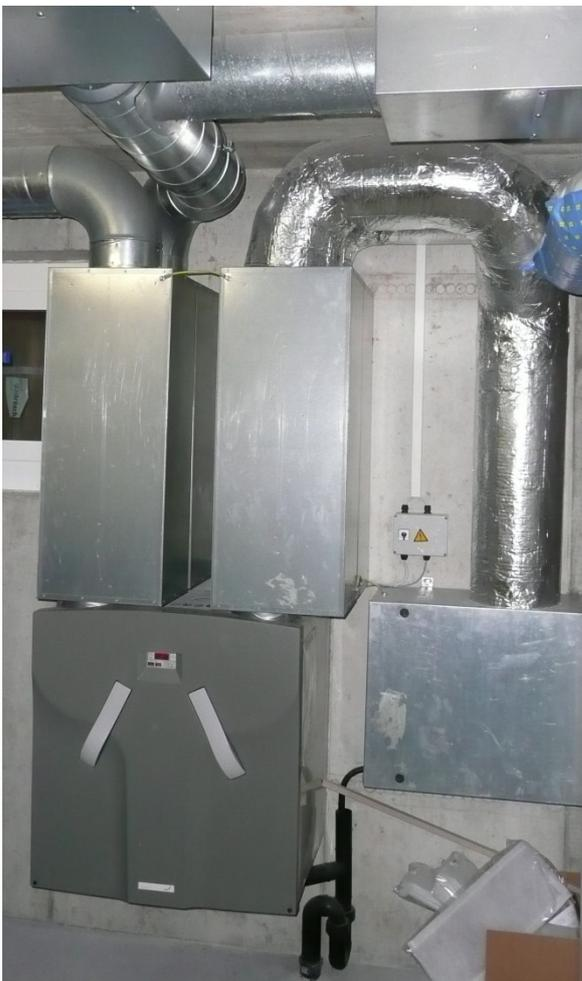
Lüftungsanlage mit Revisionskasten des Luft-Erdwärmetauschers (rechts) und Kondensatablauf mit Siphon(unten)
