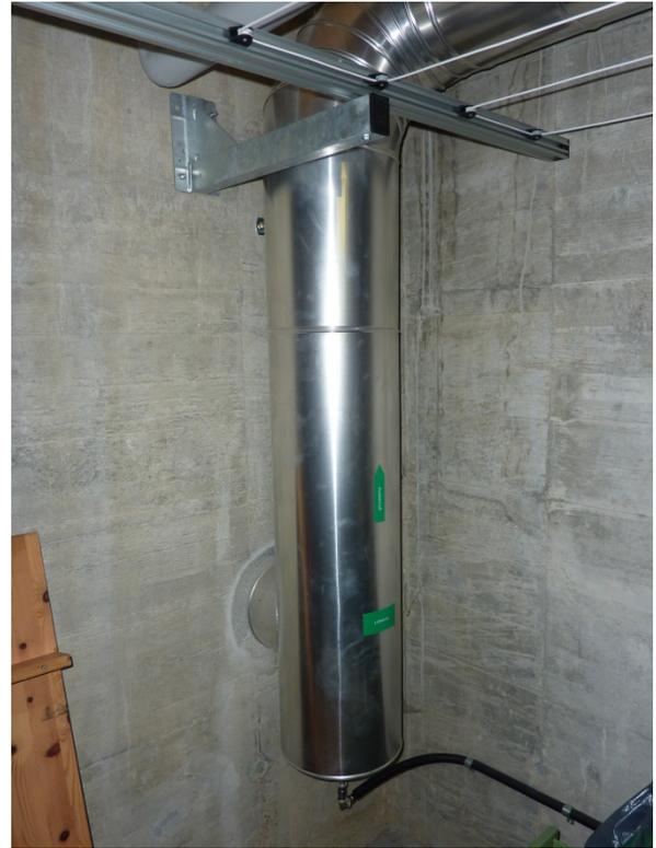
Mauerdurchführung des L-EWT mit Kondensatablauf auf der Unterseite (dünnes Rohr)
