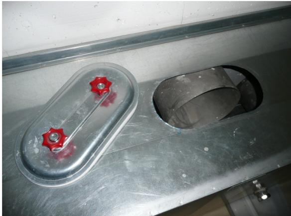
Revisionsöffnung des Luft-Erdwärmetauschers und L-EWT-Rohr
