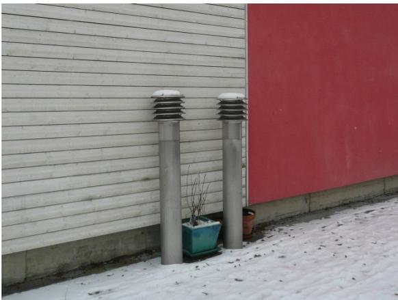
Abb. 15. Aussenluftfassung des REFH Nebikon. Der Ansaugpunkt liegt bei ca. 1.6 m über dem Terrain.
