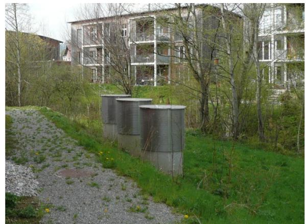
Abb. 16. Aussenluftfassungen des Verwaltungsgebäudes Sempach. Der Ansaugpunkt liegt bei ca. 1.5 m über dem Terrain.
