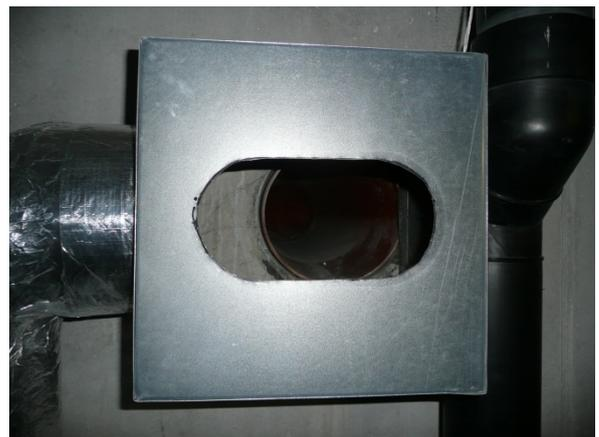
Revisionsöffnung und Mauerdurchführung des Luft-Erdwärmetauschers
