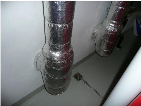
Mauerdurchführung der Luft-Erdwärmetauscher
