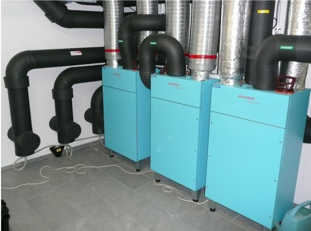
Technikraum mit den 3 Lüftungsgeräten (UG, EG, OG) und die 3 Mauerdurchführungen der Luft-Erdwärmetauscher mit Kondensatablauf (links)
