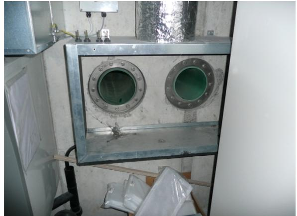
Revisionsöffnung und Mauerdurchführung des Luft-Erdwärmetauschers (2 Rohre)
