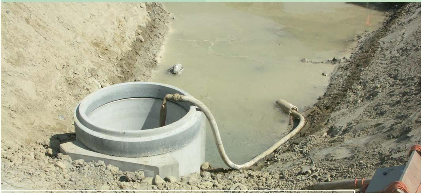
Falsche Abwassereinleitung auf einer Baustelle (Absetzbecken u. Neutralisationsanlage fehlen)
