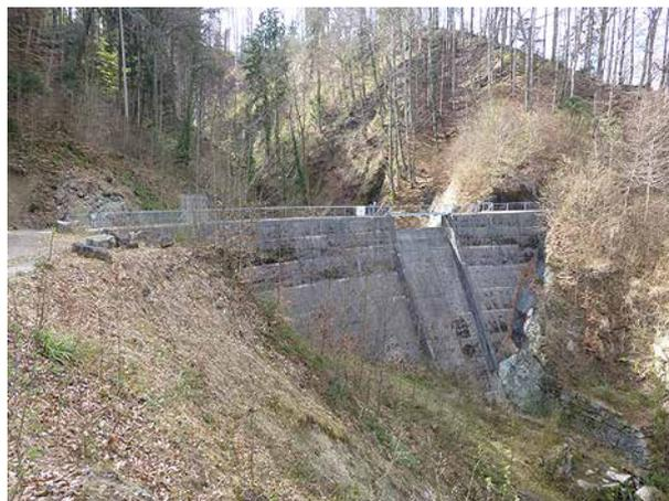
**Bild 140** *Betonstaumauer des Hochwasserrückhaltebeckens mit Hochwasserentlastung in der Mauermitte, Blick bachaufwärts (2.4.2014).*
