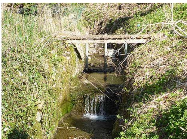
**Bild 178** *Kleiner Schwemmholzrechen oberhalb der Eindolung unter den SBB Gleisen (2.4.2014).*
