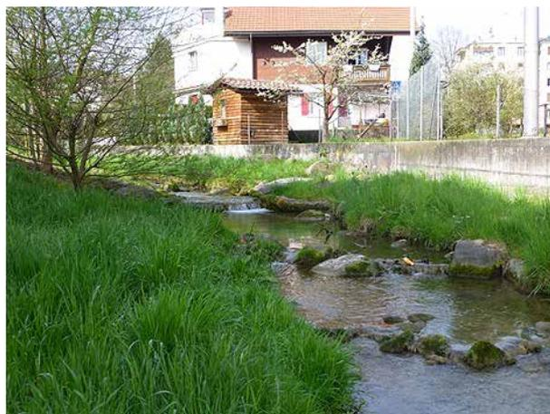
**Bild 99** *Flache Blockschwellen kurz vor der Hochwasserentlastung (7.4.2014).*
