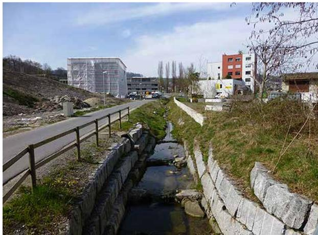
**Bild 134** *Revitalisiertes Gerinne oberhalb des Sammlers mit leicht pendelndem Lauf. Der Einlaufbereich (Vordergrund) ist mit Quaderblöcken verbaut (2.4.2014).*
