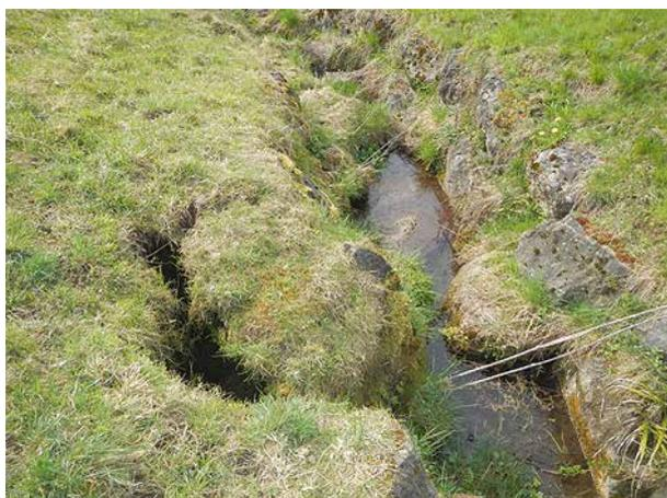
**Bild 54** *Aufgrund des stark eingeeengten Gerinnes unterspülter Uferschutz unterhalb des Sammlers (Blick bachabwärts, 27.3.2014).*
