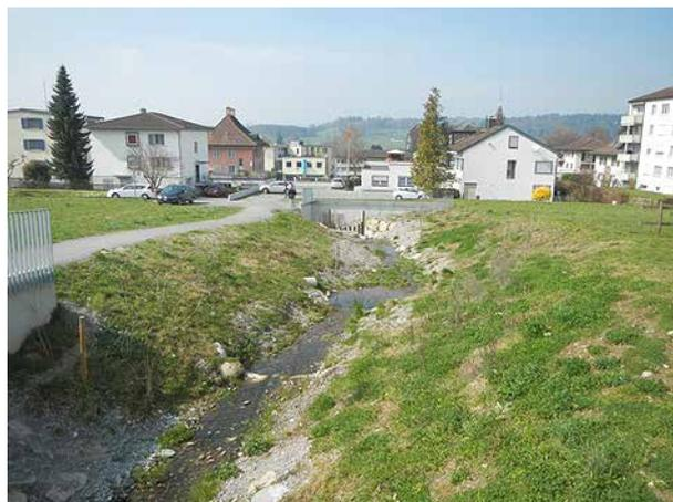
**Bild 44** Vor kurzem ausgedoltes Gerinne bachaufwärts des Schwemmholzrechen (Blick bachabwärts). Die Sohle ist mit Blockschwellen verbaut (27.3.2014).
