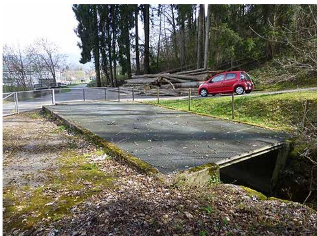
**Bild 147** *Mit Gittern abgedecktes Betonbecken des Geschiebesammlers, Blick bachabwärts (2.4.2014).*
