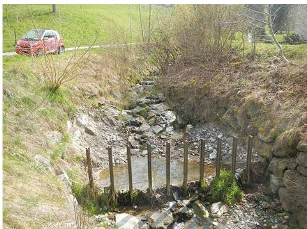
**Bild 25** Blick in den Geschiebesammler bachaufwärts. Die Ufer und der Einlaufbereich sind mit Blöcken verbaut (27.3.2014).
