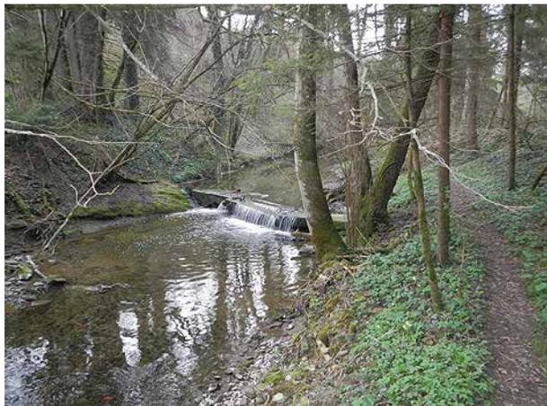
**Bild 92** *Kleine Betonschwelle zur seitlichen Wasserfassung mittels Rohr (27.3.2014).*
