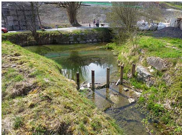
**Bild 137** *Auslaufbauwerk mit betonierter Schwelle und Aufgesetztem Schwemmholzrechen aus Eisenbahnschienen (2.4.2014).*
