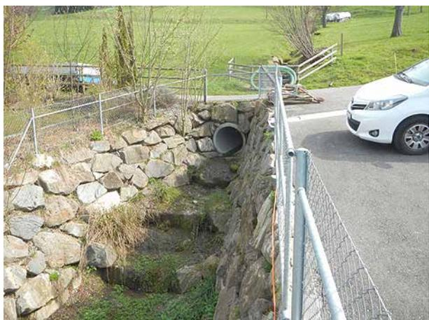
**Bild 49** Einlauf in den Geschiebesammler mit Blockschwellen (Blick bachaufwärts, 27.3.2014).
