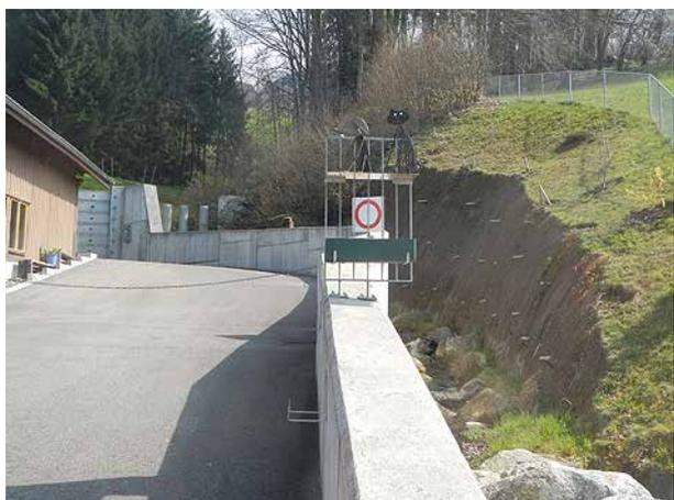
**Bild 31** Blick bachaufwärts auf die Engstelle unterhalb des Geschiebesammlers mit der künstlich angelegten, übersteilen Böschung (27.3.2014).
