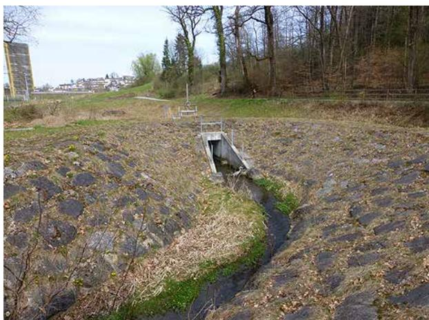
**Bild 122** Mit Blöcken verstärkter Staudamm des Rückhaltebeckens mit Blick bachaufwärts (2.4.2014).
