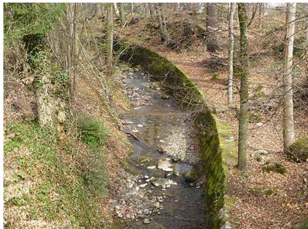
**Bild 153** *Eingeengtes und stark verbautes Gerinne unterhalb des Hochwasserrückhaltebeckens. Trotz Einengung sind Geschiebeablagerungen erkennbar (2.4.2014).*
