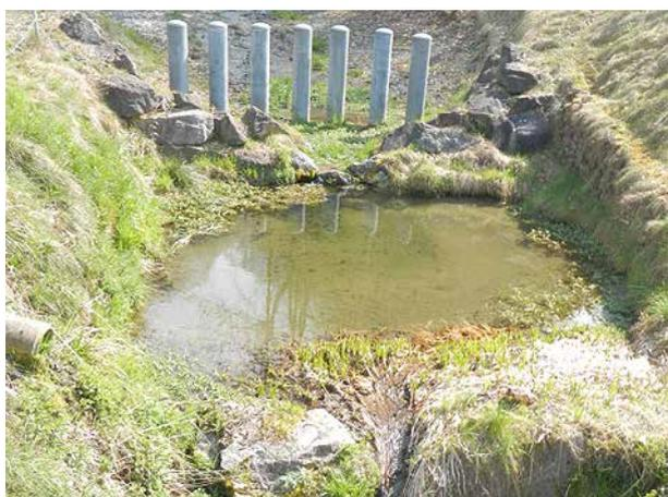
**Bild 15** *Eingestaute Blockschwelle kurz vor Rohrauslass (Blick bachaufwärts). Die V-förmige Blockschwelle bachabwärts des Rechen führt bei Hochwasser ebenfalls zu einem Rückstau (27.3.2014).*
