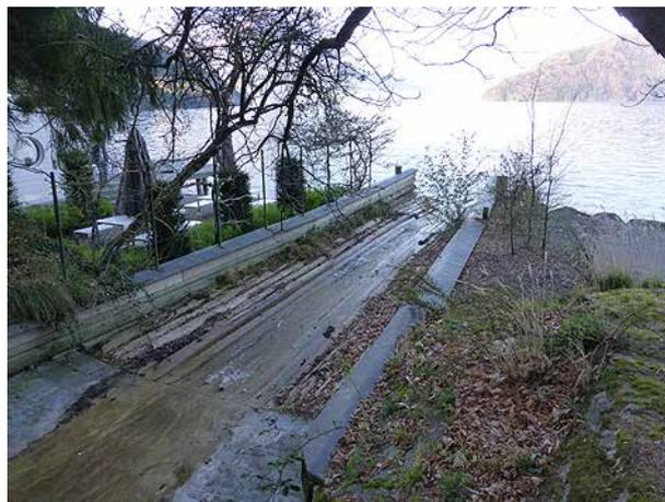
**Bild 169** Mit Rundhölzern verbaute Mündung des Altdorfbachs. Am Ende des Holzkastens besteht ein Absturz in den Vierwaldstättersee (2.4.2014).
