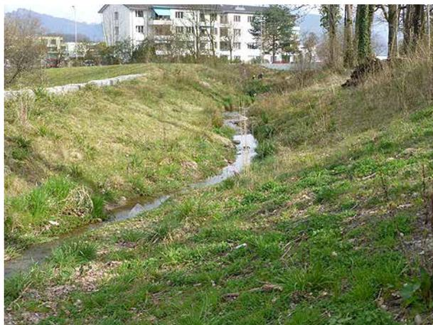
**Bild 133** Revitalisiertes Gerinne unterhalb des Sammlers mit leicht pendelndem Verlauf und einzelnen Blöcken als Strukturelemente (2.4.2014).
