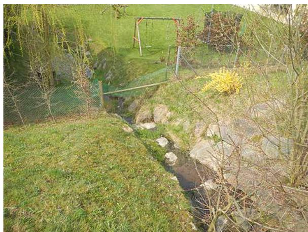
**Bild 50** Stark verbautes Gerinne mit Ufer- und Sohlensicherung aus Blöcken unterhalb des Geschiebesammlers (27.3.2014).
