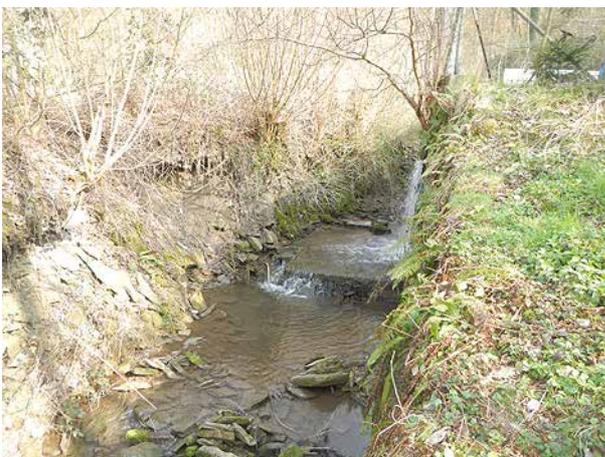
**Bild 69** *Betonschwelle und Ufermauer entlang des Stauweihers (Blick bachaufwärts). Das Ufer auf der rechten Bildseite wurde teilweise erodiert (27.3.2014).*
