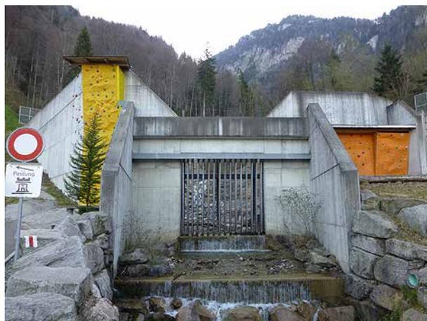
**Bild 166** Blick von unten auf das Auslaufbauwerk des Geschiebesammlers mit Rechtecköffnung und Feinrechen (2.4.2014).
