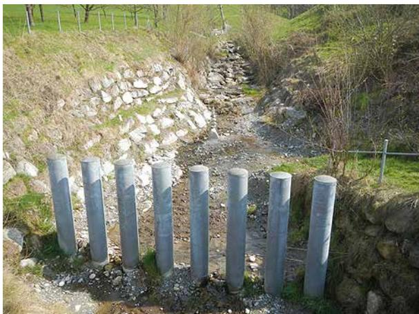
**Bild 20** Blick in den Geschiebesammler bachaufwärts. Die Ufer und der Einlaufbereich sind mit Blöcken verbaut (27.3.2014).
