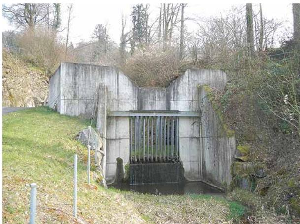
**Bild 59** *Blick bachaufwärts auf die Betonsperre mit Tosbecken (Vordergrund) und Feinrechen (27.3.2014).*
