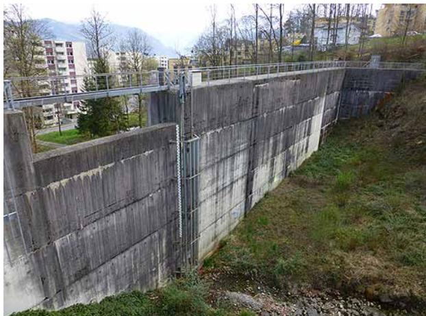
**Bild 152** *Betonstaumauer des Hochwasserrückhaltebeckens mit Hochwasserrückhaltung und gedrosseltem Grundablass am unteren Bildrand (2.4.2014).*
