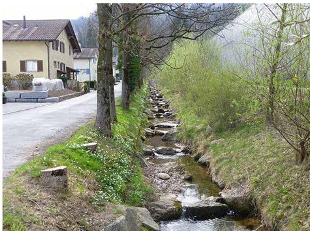
**Bild 154** Stark verbautes Gerinne mit regelmässigen Blockschwellen oberhalb des Sammlers. Zwischen den Schwellen sind kleine Kiesbänke vorhanden (2.4.2014).
