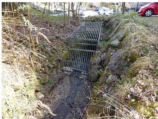
**Bild 189** *Vor den untersten zwei Rechen sind Ablagerungen von Feingeschiebe erkennbar (2.4.2014).*
