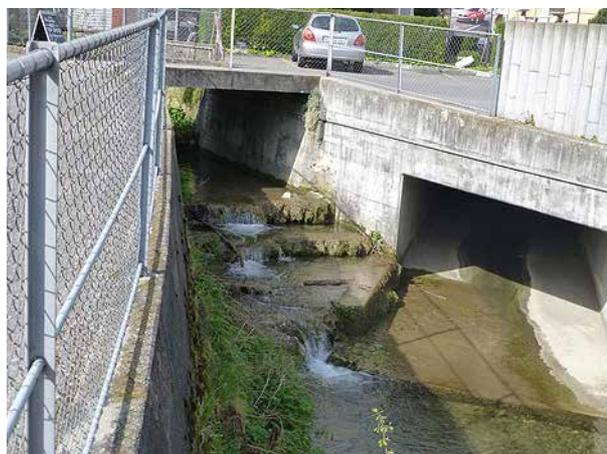
**Bild 102** *Absturz über mehrere enge Blockschwellen vor dem Rücklauf des Entlastungskanals, Blick bachaufwärts (7.4.2014)*
