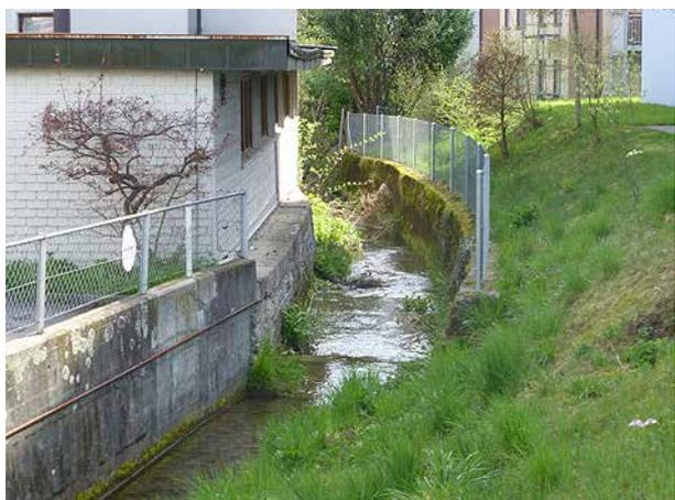
**Bild 101** *Eingeengtes und mit Ufermauern verbautes Gerinne unterhalb der Entlastung (Blick bachabwärts, 7.4.2014).*
