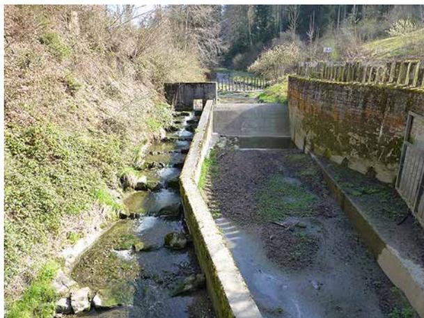
**Bild 181** *Blick bachaufwärts in die Hochwasserentlastung mit Schwemmholzrechen (Hintergrund), seitlicher Entnahme (rechts) und fischgängiger Niederwasserrinne (links, 2.4.2014).*
