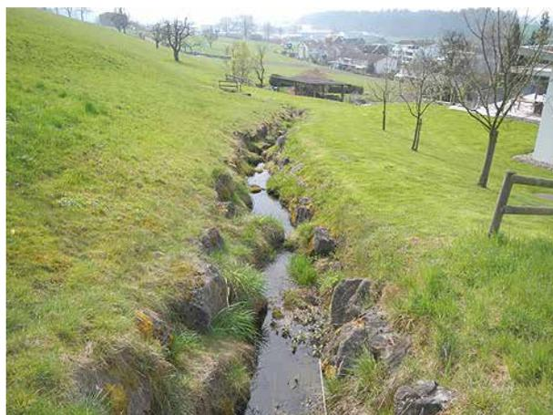
**Bild 55** *Stark eingeeengtes und mit Blöcken verbautes Gerinne unterhalb des Geschiebesammlers (27.3.2014).*
