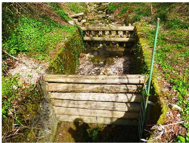
**Bild 163** *Blick bachaufwärts auf die zwei Holzrechen. Gut erkennbar ist das nach dem oberen Rechen abgelagerte Groschutt (2.4.2014).*
