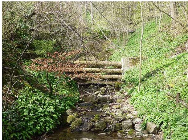
*Bild 211 Betonrückhaltesperre mit Horizontalrechen aus Rundhölzern etwas oberhalb der Eindolung (2.4.2014).*
