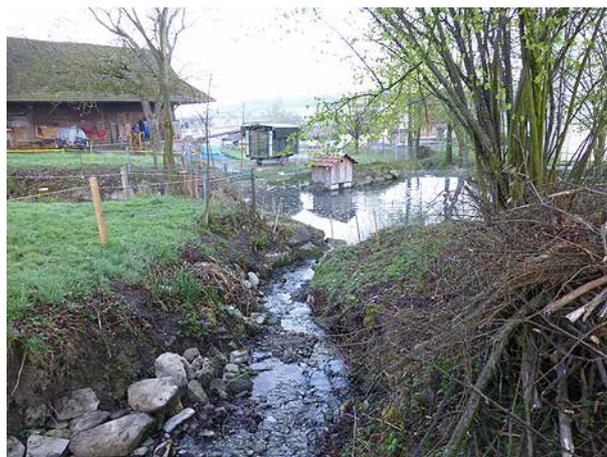
**Bild 62** *Einlauf in den Geschiebesammler. Die Ufer wurden teilweise unterspült und mit Blöcken gesichert (7.4.2014).*
