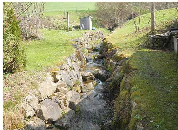
**Bild 37** *Stark verbautes Gerinne mit Ufer- und Sohlensicherung aus Blöcken am oberen Ende des Siedlungsgebiets (27.3.2014).*
