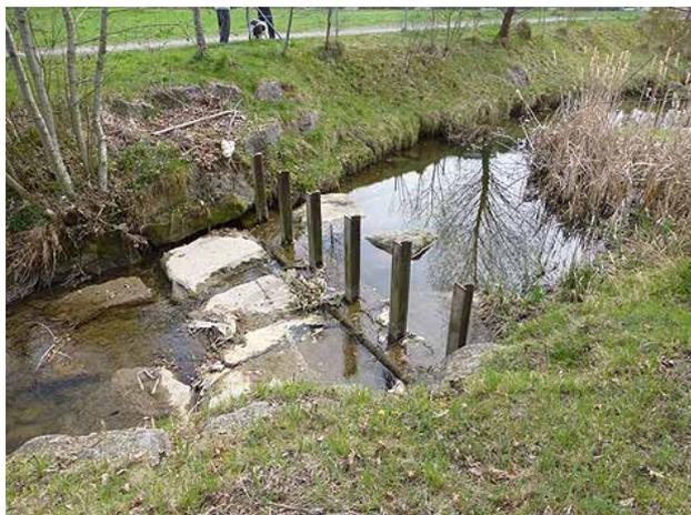
**Bild 157** Auslaufbauwerk mit betonierter Sohlschwelle und aufgesetztem Schwemmholzrechen aus Eisenbahnschienen (2.4.2014).
