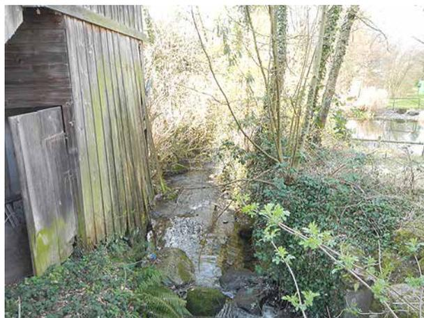
**Bild 80** *Eingeengtes und stark verbautes Gerinne im Siedlungsgebiet von Ebikon unterhalb der Wasserfassung (27.3.2014).*
