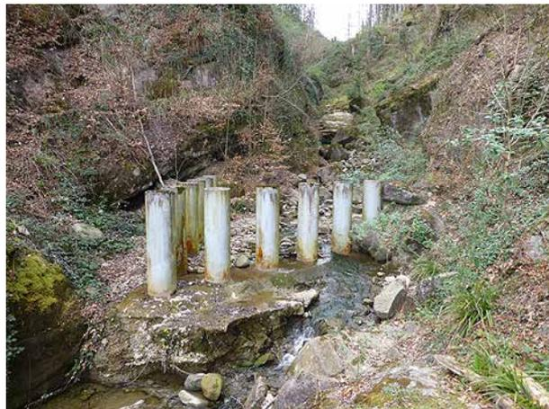
**Bild 150** *Schwemmholtzrechen aus Stahlstäben am Ende der Tobelstrecke, Blick bachaufwärts (2.4.2014).*
