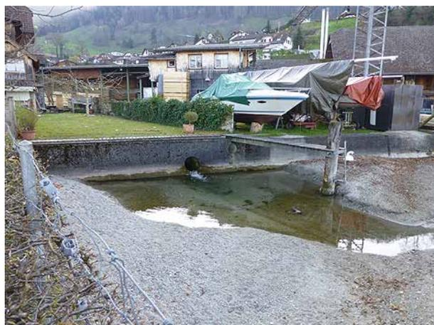
**Bild 174** Mündung (Rohr) des Mühlebachs in den Vierwaldstättersee mit grösseren Sandablagerungen (2.4.2014).
