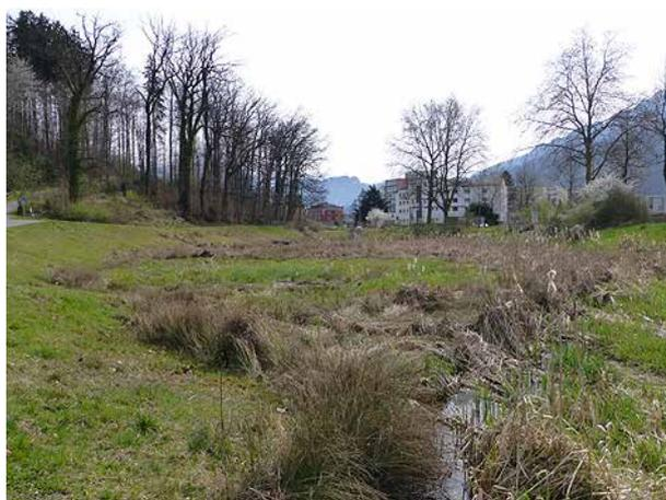
**Bild 120** Blick bachabwärts in den unteren Teil des Rückhaltebeckens. Das Gerinne ist stark verwachsen (2.4.2014).
