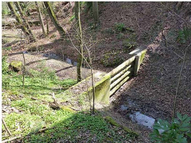
**Bild 201** *Obere Rückhaltesperre unter der Bücke der Sankt Niklausstrasse. Oberhalb der Sperre sind keine Ablagerungen erkennbar (2.4.2014).*
