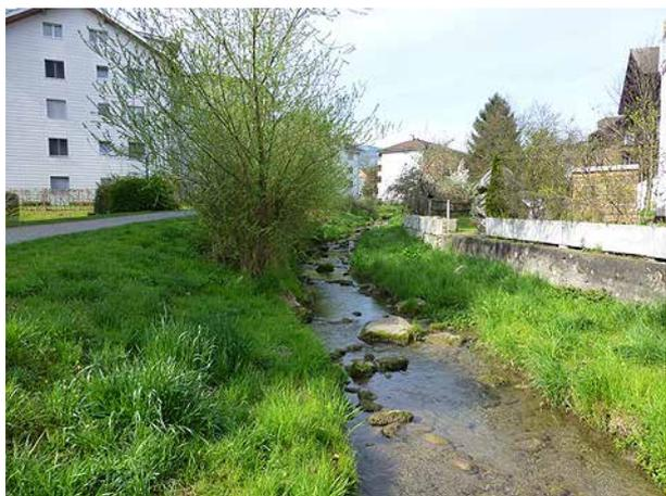
**Bild 98** *Revitalisiertes Gerinne oberhalb der Entlastung mit punktuellen Ufer- und Sohlensicherungen aus Blöcken (7.4.2014).*
