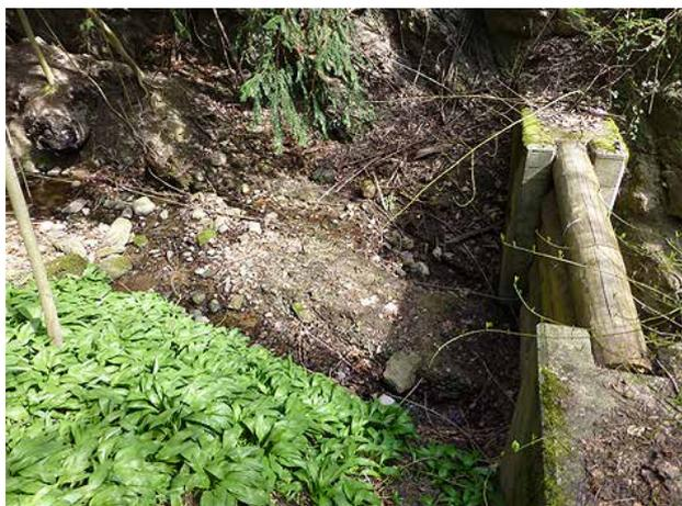
**Bild 208** Geringfügige Geschiebeablagerungen hinter der oberen Rückhaltesperre (2.4.2014).
