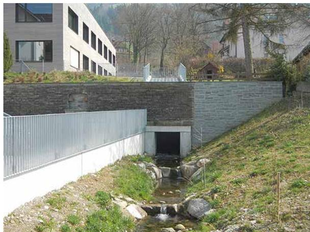
**Bild 42** *Zugemauerte Betonschwelle von der Schulhausstrasse bachaufwärts gesehen. Das Gerinne unterhalb wurde ausgedolnt und ist mit Blockschwellen verbaut (27.3.2014).*
