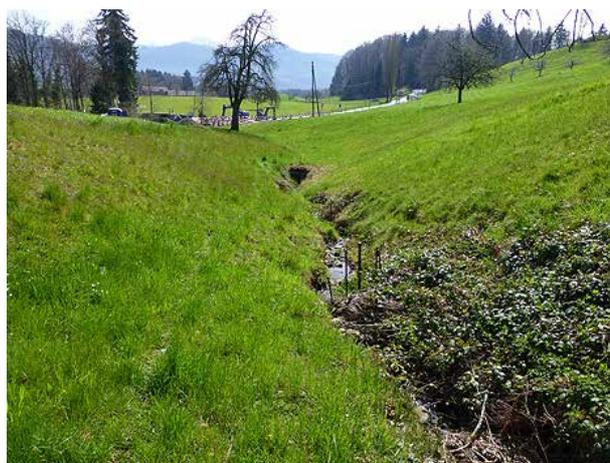
**Bild 199** *Enges mit Steinen verbautes Gerinne vor der Eindolung unter der Mättliwilstrasse. Im Vordergrund ist ein improvisierter Schwemmholtzrechen aus Eisenstangen sichtbar (2.4.2014).*
