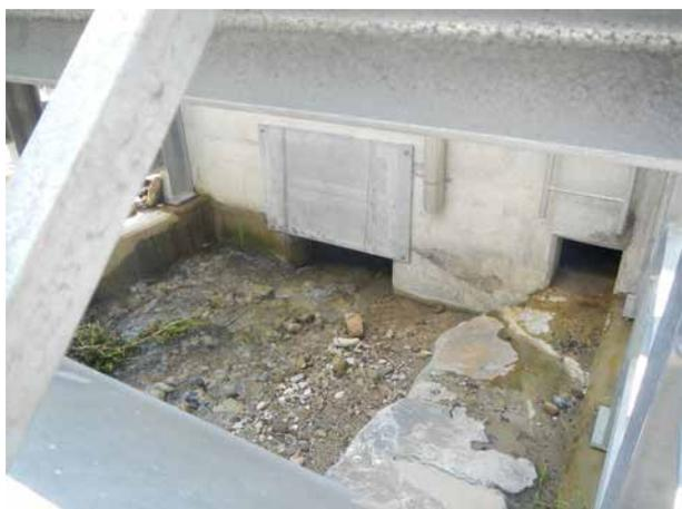
**Bild 39** Schieber vor Grundablass (links) und Kleintierdurchlass, Blick in Fließrichtung.
