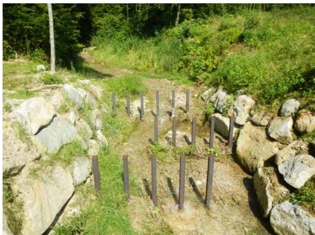
**Bild 36** Grobrechen bachaufwärts des Hochwasserschutzdammes, Blick gegen die Fließrichtung.
