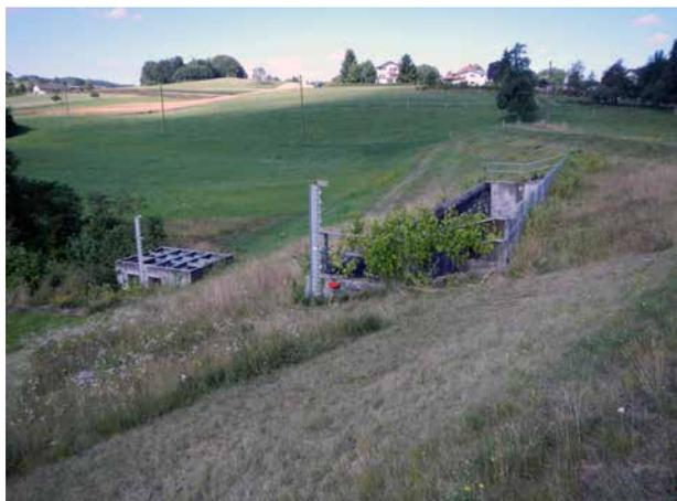
*Bild 83 Drosselbauwerk (links) und Entlastungsbauwerk (rechts).
