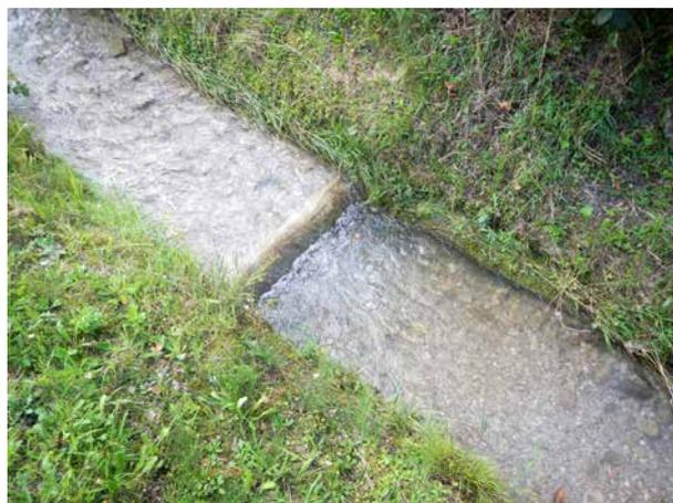
**Bild 26** Gerinne bei der Kirche. Die schmale, mit Schwellen verbaute Sohle ist mit lockeren Kiesablagerungen bedeckt. Fliessrichtung von links nach rechts.
