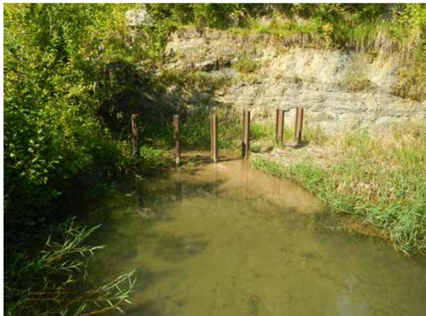
*Bild 47 Oberer Bereich des Rückhalteraumes mit Holzrechen und Sandablagerungen.
