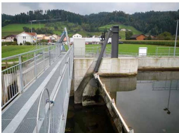
**Bild 61** Wehranlage mit automatisch absenkbarer Stauklappe.
