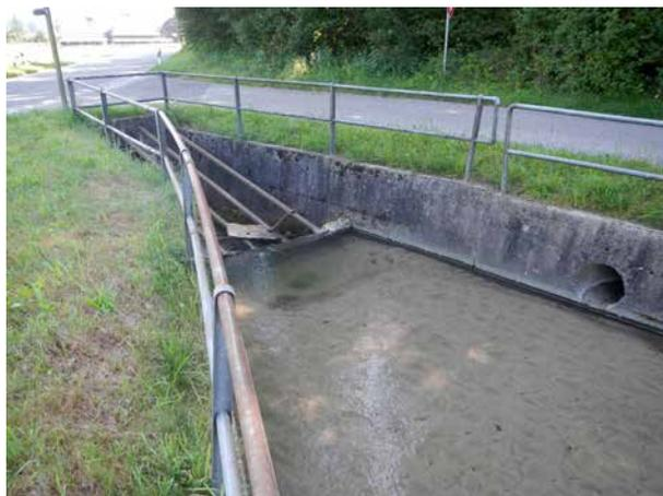
**Bild 74** Sandablagerungen im unteren Bereich des Rückhalteraumes. Blick in Fliessrichtung.
