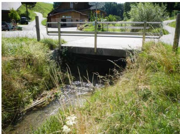
*Bild 68* *Brücke Lochmühle mit geringer Durchflusshöhe und breiter Sohle. Blick gegen die Fliessrichtung.*
