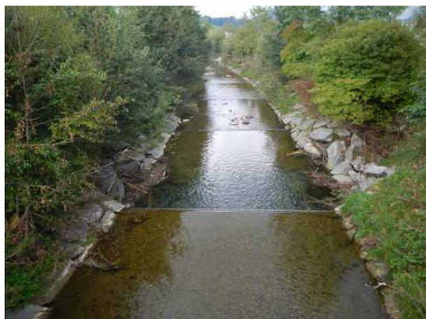
**Bild 62** Hart verbautes Gerinne im Unterwasser des Wehres. Die Schwellenzwischenräume sind mit Kies hinterfüllt. Blick ab Brücke Guggistrasse in FR. 09.09.2014
