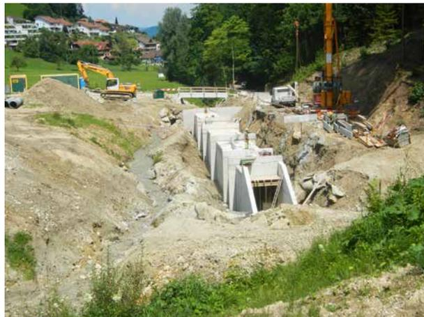
**Bild 23** Standort des vorgesehenen Dammes mit Betriebsauslass im Bau. Blick in Fliessrichtung.
