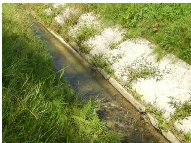
**Bild 76** Mit Betonplatten und Holz hart verbautes Gerinne bachabwärts des Sammlers. Blick gegen die Fliessrichtung.
