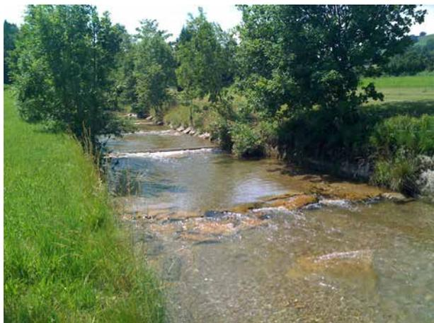
**Bild 58** Luthern im Bereich Chratzere ca. 800m flussaufwärts des Wehres Gettnau. Befestigte Ufer, eng aufeinanderfolgende Schwellen, kaum Strukturen.
