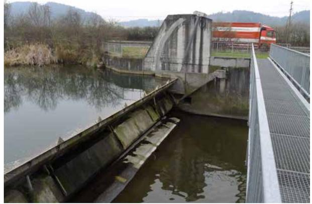
**Bild 2** Wehr Lang mit Segmentklappenschütze. 26.03.2014
