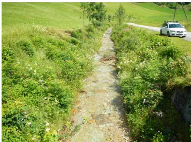
**Bild 65** Änzibach zwischen dem Waffenplatz und der Einmündung in die Luthern. Sohle und Ufer sind durchgehend verbaut. 25.07.2014
