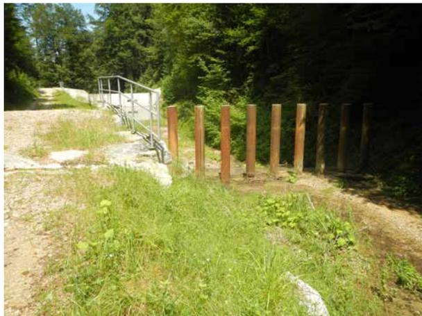
*Bild 18 Holzrechen mit Geschiebesammler im Hintergrund. Blick in Fliessrichtung.
