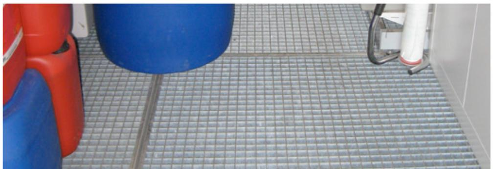
Dank der mit Gitterrost ausgerüsteten Wanne kann das Löschwasser im selben Lagerraum zurückgehalten werden.
