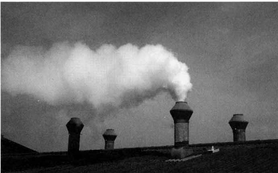
Abb. 1. Die Abluft aus Tierhaltungsanlagen kann zu Geruchsbelästigungen führen. Durch geeignete Massnahmen (Stallsystem, Lüftung, Fütterung, Abstände) kann diese Belästigung auf ein vertretbares Mass reduziert werden.
