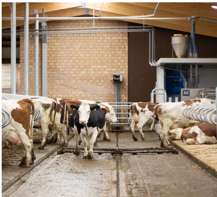
Abbildung 2: Stall mit erhöhtem Fressplatz und Fressgang mit seitlichem Gefälle Foto: Monique Wittwer im Rahmen des Ressourcenprojekts ZCH
