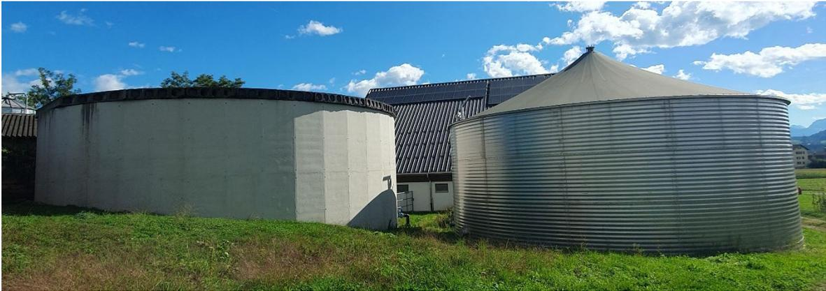
**Abb. 3:** Feste Konstruktionen, Spannbeton-Hohldecken (links) und Zeltdach aus Kunststoff (rechts).
