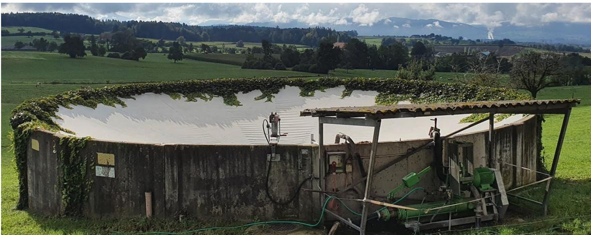
**Abb. 1:** Teilschwimmende Abdeckung, Schwimmfolie. Bild: Dienststelle uwe.
