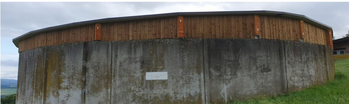
**Abb. 2:** Feste Konstruktion, individuelle Holzabdeckung oder Stahlkonstruktion. Im Bild zu sehen ist eine bewilligungsfreie Konstruktion mit Firsthöhe < 120 cm gemessen ab Silooberkante. Bild: Dienststelle uwe.
