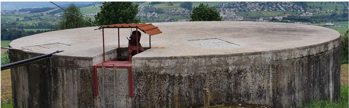
**Abb. 4:** Feste Konstruktion, Ortsbetondecke. Bild: Dienststelle uwe.
