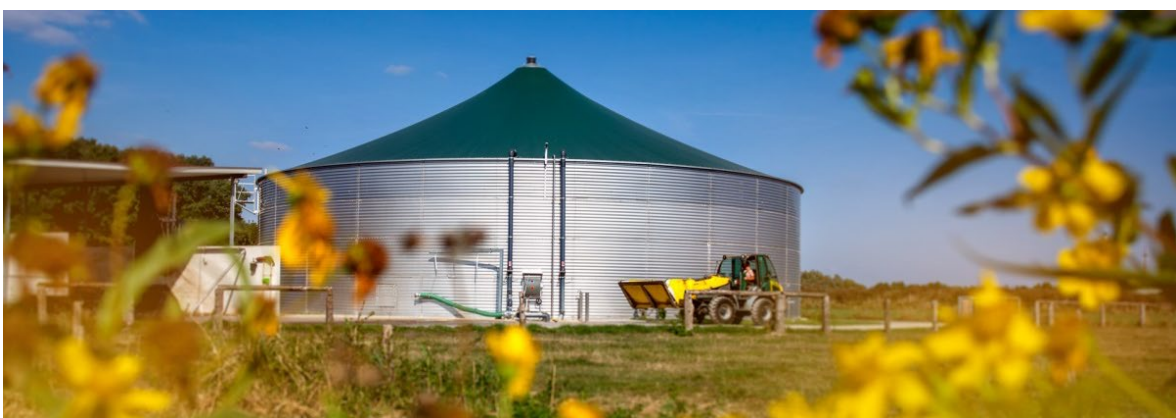
Abb. 2: Feste Konstruktion, Zelt Dach aus Kunststoff. Bild: ATG GmbH, Gettnau.
