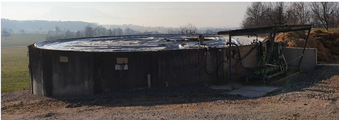
Abb. 1: Teilschwimmende Abdeckung, Schwimmfolie. Bild: Dienststelle uwe.
