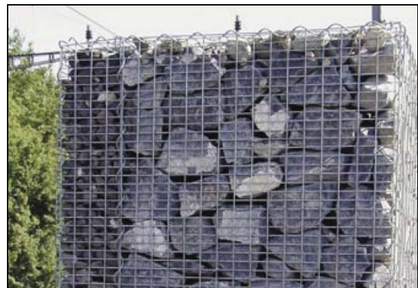
Abb. 4.20 Schallabsorbierende Steinkörbe Quelle: Publikation SBB-Lärmsanierung mit Steinkörben, Niklaus Buck, System Bossard + Staerke AG, 6301 Zug
