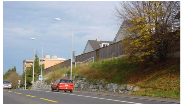
Abb. 4.15 Holzlärmschutzwand, Wohnüberbauung Kapf, Emmenbrücke LU
