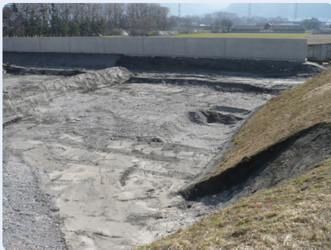
Bei der Sanierung einer Schiessanlage wird der Oberboden abgetragen (Foto: VBS).
