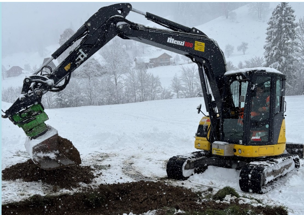
Abbildung 2: Technische Untersuchung mittels Baggerschacht auf ei- ner ehemaligen Deponie bei winterlichen Verhältnissen im Entlebuch. Foto: F. Koller (Solgeo AG)
