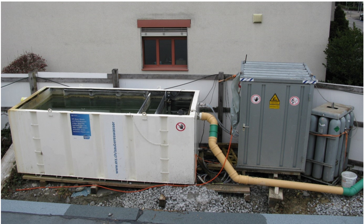
Abbildung: Kombibecken (Absetz- und Neutralisationsbecken) für die Vorbehandlung von Baustellenabwasser
