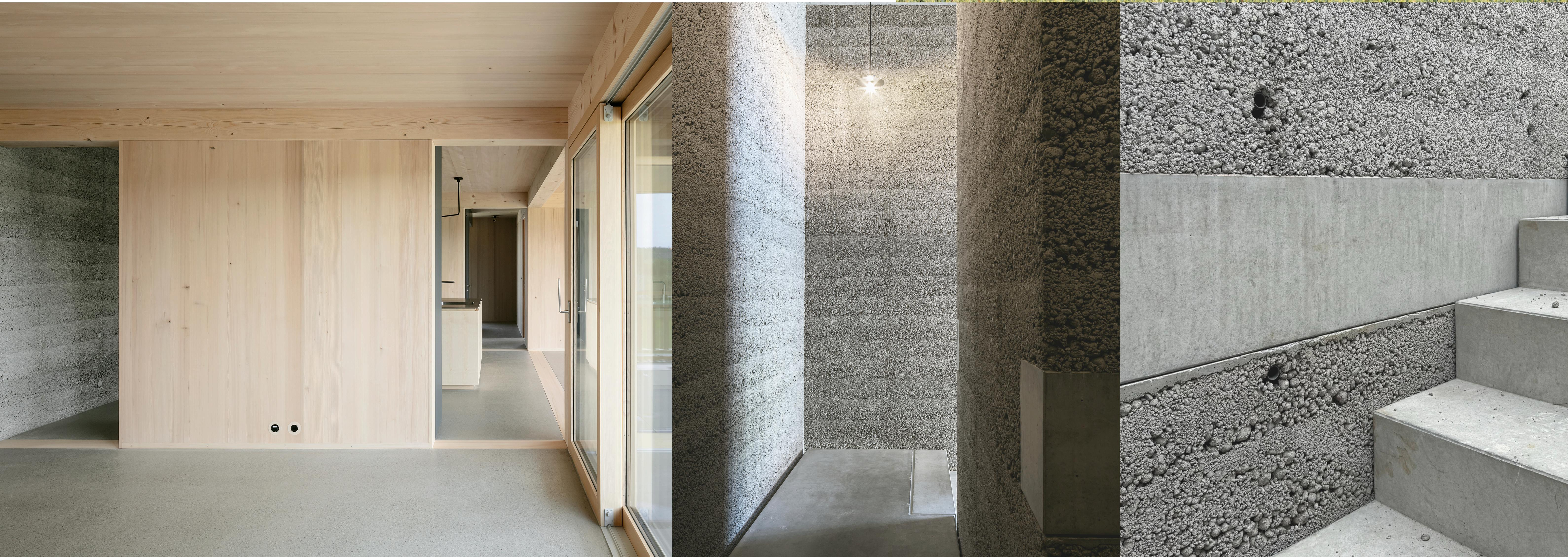
Fertigelementen aufgelegt, die wiederum nur auf den gestampften Liftwänden abgelegt sind. Dabei wird nichts verschraubt, mit Metallteilen verankert oder gar fest betoniert. Das statische Prinzip der Druckfestigkeit funktioniert aufgrund des Eigengewichts bzw. der Masse des Stampfbetons und der Elemente sowie der ausgewogenen Balance der Kräfte innerhalb der Treppenanlage.
