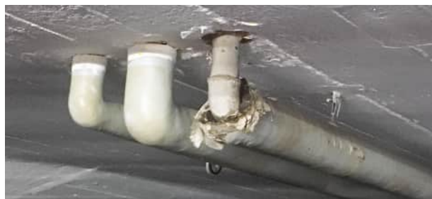
Defekte Wärmedämmungen reparieren.
